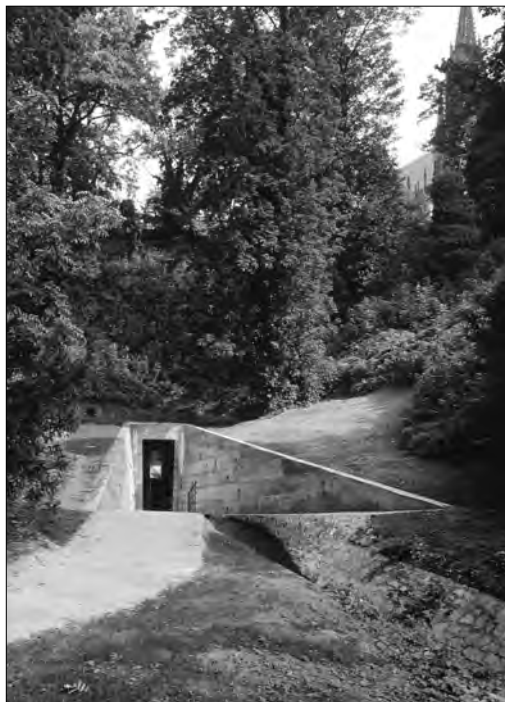
Obr. 4: Západní vstup do průchodu valem Prašného mostu (podle Mitášová 2004 ).
