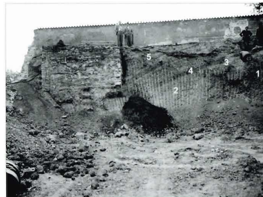
Obr. 13: Terasa Jízdárny. Bourání ohradní zdi na západní straně Jízdárny. Pohled od východu. Na profilu vpravo dole letenské souvrství sklánějící se k jihu do Jeleního příkopu (1), světlejší poloha deluvia (2) pokrytá spraší (3), nad nimi tmavý půdní horizont (4), svrchní část tvoří hlinitokamenité antropogenní navážky (5). Vpravo nahoře vybírání hrobových jam zahloubených z povrchu půdního horizontu. Foto I. Borkovský 1951.
