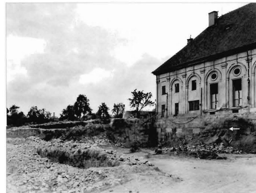
Obr. 14: Terasa Jízdárny. Obnažený jihozápadní roh Jízdárny. V pozadí v západní stěně stavební jámy zřetelné uložení vrstev letenského souvrství sklánějících se k jihu do Jeleního příkopu. Šipkou označena úroveň povrchu „skály“ na jižní základové zdi Jízdárny. Foto I. Borkovský 1951.
