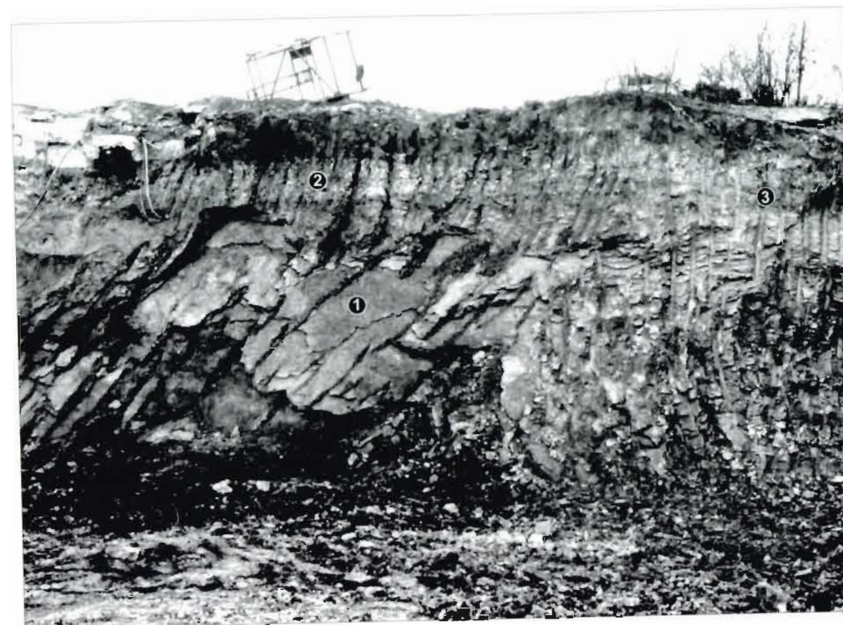
Obr. 1: Stavební jáma pro energocentrum západně Jízdárny. Pohled na východní část severní stěny. K jihu skloněné vrstvy letenského souvrství (1), nad nimi ostře vyvinutá hranice deluvií (2, světlejší), ve svrchní části 2 – 3 m násypů. Vpravo nahoře štěrky terásy Brusnice jako malý zbytek (3). Foto Z. Kopřiva (in Řepka 1988 ).
