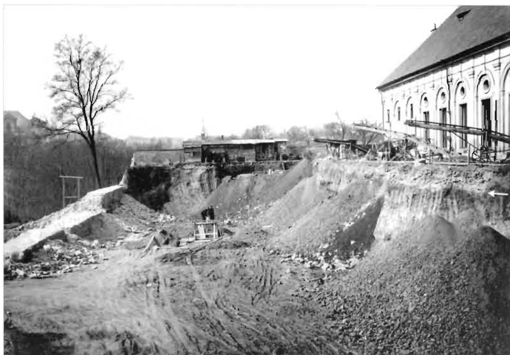
Obr. 16: Terasa Jízdárny. Pohled od východu na odbouranou plochu. V severní stěně stavební jámy rozhraní novověkých navážek a původního půdního horizontu (označeno šipkou). V západní stěně patrný sklon vrstev k jihu k ohradní zdi nad Jelením příkopem. Foto I. Borkovský 1951. Abb. 16: Terrasse der Reitschule. Blick von Osten auf die abgetragene Fläche. In der Nordwand der Baugrube sieht man die Grenze zwischen neuzeitlichen Aufschüttungen und ursprünglichem Bodenhorizont (mit Pfeil bezeichnet). In der Westwand ist die Neigung der Schichten nach Süden zur Umfassungsmauer über dem Hirschgraben sichtbar. Foto I. Borkovský 1951.
