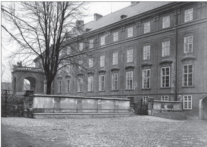
Obr. 2/4: Praha – Hrad, IV. hradní nádvoří před zahájením úprav a výkopových prací v roce 1930. Č. neg. 2271.
