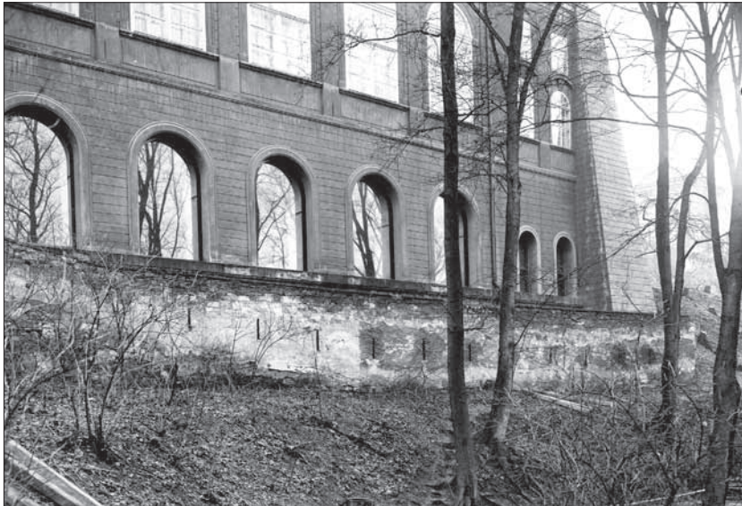
Obr. 2/11: Praha – Hrad, II. nádvoří, zákoutí u kaple sv. Kříže. Zkoumaná plocha po skončení výzkumu, hroby se nacházely v levé části snímku, č. neg. 84044.
