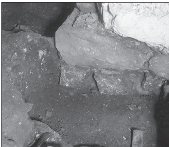
Obr. 3/64: Praha – Hrad. Č. neg. 6488, text: „S z. křídlo, kostel P. Marie, slovanská. Nárožní kámen severových. nároží lodi kostela. Světlé zdivo nahoře – barokní přízdívka severní zdi lodi kostela.“ Detail základu severovýchodního nároží lodi kostela. Patrný dva řádky zdiva základu – horního tvořeného pískovcovou deskou a spodního v líci z menších opukových kamenů. Pod nimi patrný kosti hrobu IIN052.
