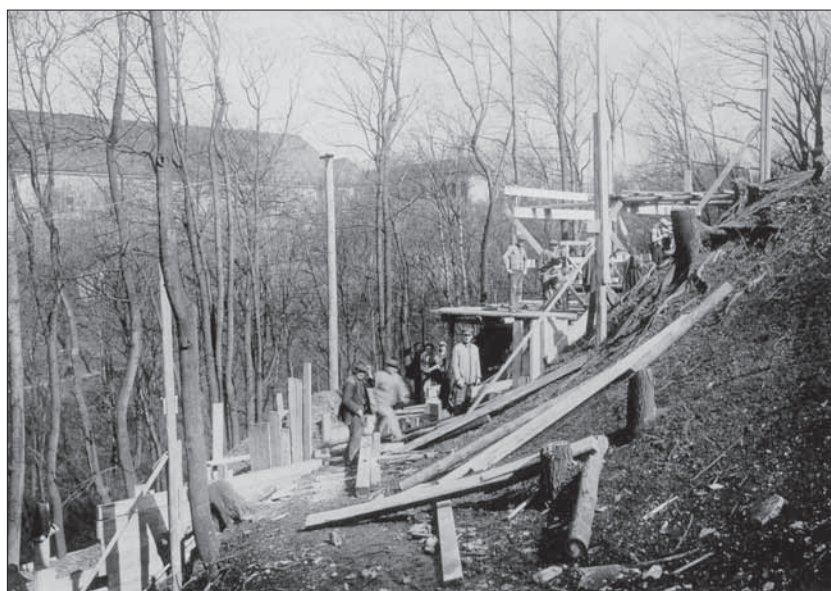
Obr. 2/5: Praha – Hrad, IV. hradní nádvoří a svah Jeleního příkopu. Hloubení sond v místě dnešní tzv. Plečnikovy lávky v roce 1930. Č. neg. 1307.
