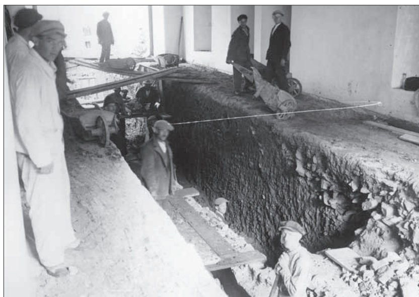
Obr. 2/3: Praha – Hrad, průjezd mezi II. a III. nádvořím 1929. Pracovní záběr na hloubení kolektoru. Č. neg. 1218.
