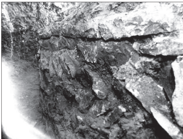
Obr. 3/94: Praha – Hrad. Č. neg. 10714, text: „ Sz. křídlo, kostel P. Marie, slovanská. Základy starší apsidy. Opus spicatum. “ Pohled na část vnějšího líce základového zdiva apsidy po vybrání archeologických terénů. Dokládá odstranění všech hrobových pozůstatků. Pohled od severu.
