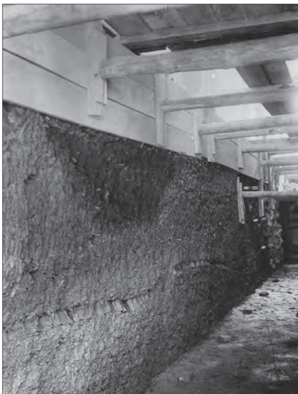
Obr. 9: Praha – Hrad, Střední křídlo, průjezd mezi II. a III. nádvořím. Pohled do výkopu z roku 1929. Ve stěně vlevo zachycen tzv. nejstarší příkop, níže skalní podloží. Č. neg. 1226.
