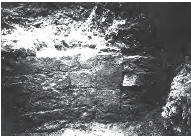
Obr. 145: Praha – Hrad, IV. nádvoří. Románský dům (OBJ. I), jižní partie západní stěny s částí ostění zazděného vstupu. Č. neg. 1396.
