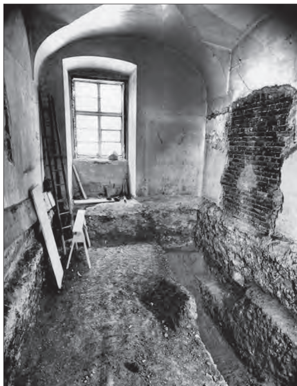
Obr. 10: Praha – Hrad, Střední křídlo, průchod mezi II. a III. nádvořím. Pracovní záběr do nedokončeného výkopu z r. 1948. Č. neg. D5566.
