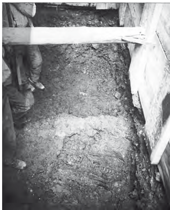
Obr. 3/10: Praha – Hrad, tzv. Kuchyňský dvorek. Fotografie dokumentující nález hrobu. Popis: „Praha – Hrad, Palác. Z románského hřbitova pod podezdívanou částí jižního průčelí (pod branou s velkou házečkou). Pohled od jihu. 19.-24. VII 1926“. Negativ č. 115.
