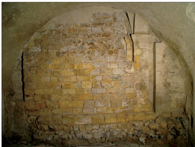
Obr. 109: Čp. 38, sklepy 1966. Východní čelo sklepa, současný stav. Foto Geo-cz, archiv ARÚ Praha, Pražský hrad.
