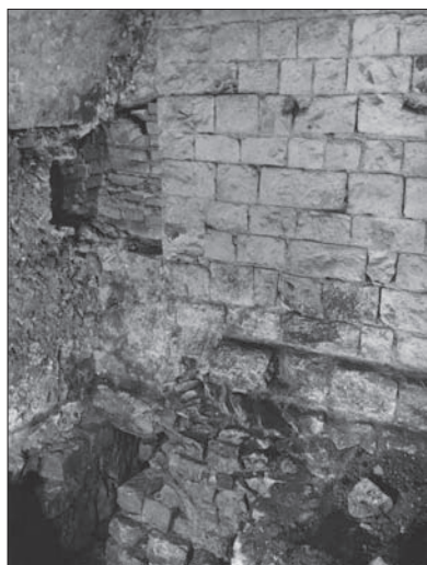
Obr. 104: Čp. 38, sklepy 1966. Východní čelo sklepa. Kvádrkové zdivo interiéru severního křídla „kláštera kostela pražského“ na styku s románskou hradbou (vlevo), archiv ARÚ Praha, Pražský hrad.
