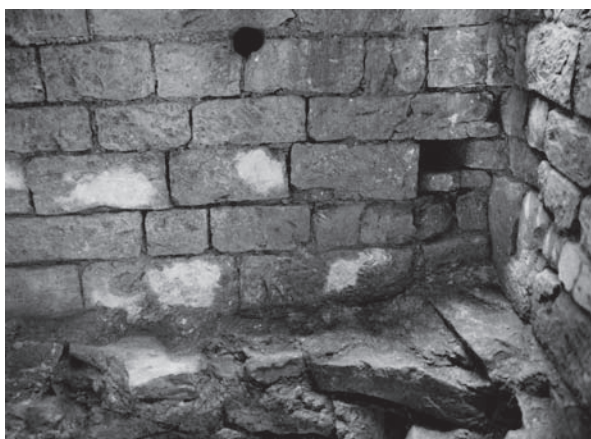
Obr. 71: Vikářská ulice 1967. Zaklenutá místnost v severním křídle „kláštera kostela pražského“, pohled na vnitřní líc jižní zdi, archiv ARÚ Praha, Pražský hrad.
