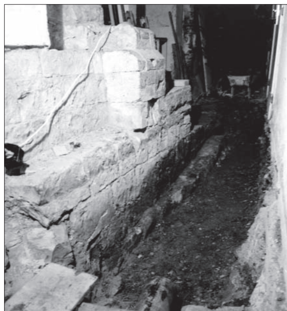
Obr. 113: Sklepy čp. 40, 1985. Stupňovitý vnitřní líc románské kamenné hradby. Foto J. Frolík, archiv ARÚ Praha, Pražský hrad.
