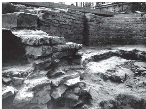
Obr. 44: Severní apsida baziliky sv. Víta, stav při výzkumu, pohled do interiéru, APH, Fond Jednota.
