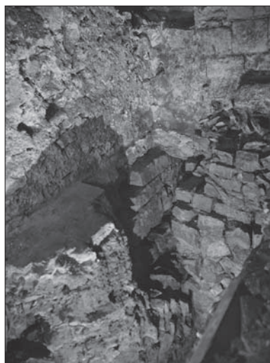
Obr. 105: Čp. 38, sklepy 1966. Východní čelo sklepa. Kvádrkové zdivo interiéru severního křídla „kláštera kostela pražského“ na styku s románskou hradbou (vlevo), archiv ARÚ Praha, Pražský hrad.
