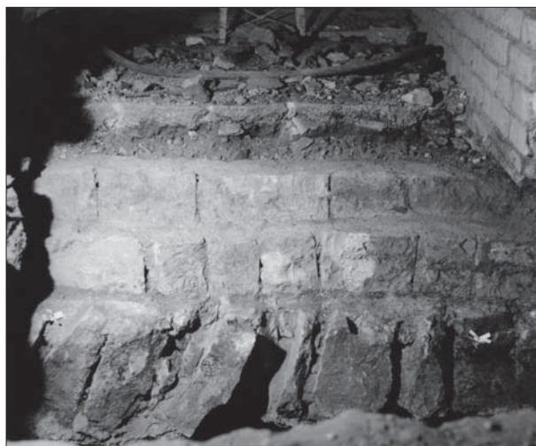
Obr. 112: Sklepy čp. 40, chodba v severní části 1985. Kvádríkové zdivo románské hradby s nikou a částí předzákladu. Foto J. Frolík, archiv ARÚ Praha, Pražský hrad.
