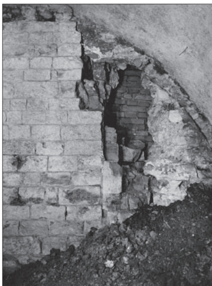
Obr. 108: Čp. 38, sklepy 1966. Východní čelo sklepa. Jižní konec kvádříkového zdiva interiéru severního křídla „kláštera kostela pražského“ s obnaženým jádrem křížového sloupku, archiv ARÚ Praha, Pražský hrad.
