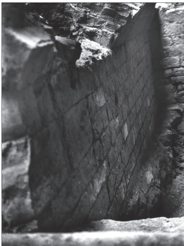
Obr. 69: Vikářská ulice 1967. Zaklenutá místnost v severním křídle „kláštera kostela pražského“, pohled na jižní zeď a západní čelo prostory, archiv ARÚ Praha, Pražský hrad.
