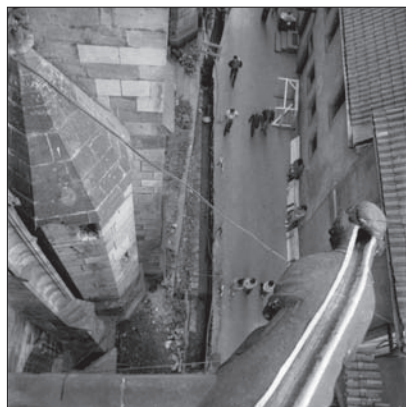
Obr. 73: Vikářská ulice 1985. Severní vnější zeď ambitu „kláštera kostela pražského“. Foto J. Frolík, archiv ARÚ Praha, Pražský hrad.
