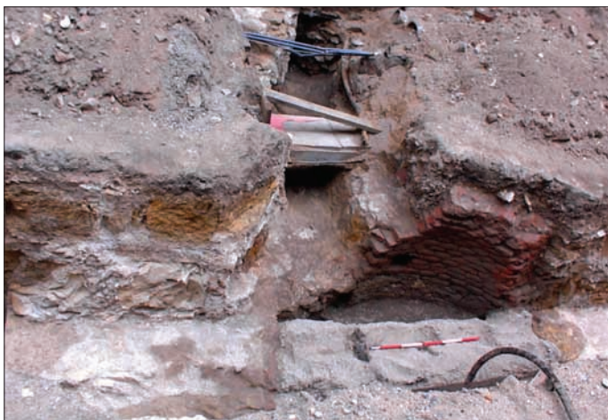
Obr. 88: Vikářská ulice 2000. Nerealizovaná severní věž katedrály, průřez západní zdi. Do zdiva vložené točité schodiště s cihlovou obezdívkou. Foto J. Frolík, archiv ARÚ Praha, Pražský hrad.
