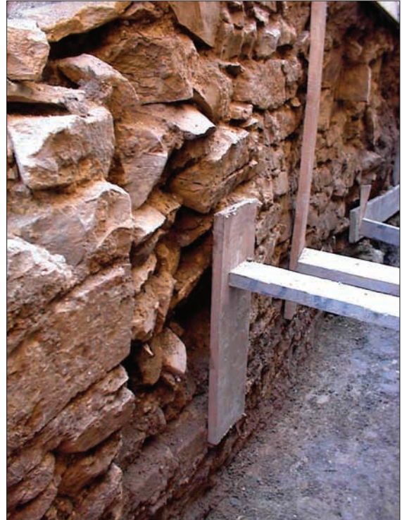
Obr. 79: Vikářská ulice 2000. Vnitřní líc jižní obvodové zdi zaniklého gotického sklepa. Vpředu zazděný otvor či výklenek. Foto J. Frolík, archiv ARÚ Praha, Pražský hrad.
