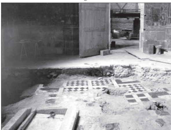
Obr. 23: Výzkum v kapli sv. Václava (1910–1911), stav po sejmutí části gotických navážek a odhalení nejmladší podlahové úrovně románské baziliky, vlevo dole hrob sv. Václava a základ oltáře, APH, Fond Jednota.
