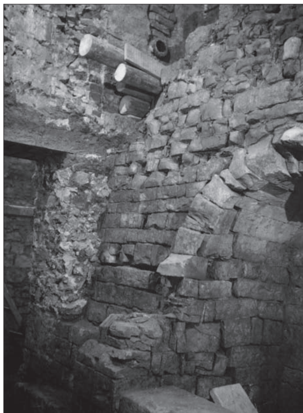
Obr. 115: Čp. 40, suterén 1965. Vnitřní líc románské kvádríkové hradby se zaklenutou nikou, archiv ARÚ Praha, Pražský hrad.
