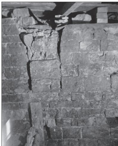
Obr. 101: Čp. 37, průjezd 1967. Východní zeď románského křídla severně od ambitu „kláštera kostela pražského“. Vnitřní líc s dochovaným sloupkem a náběhem klenby, archiv ARÚ Praha, Pražský hrad.
