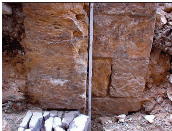
Obr. 85: Vikářská ulice 2000. Vchod do křídla „kláštera kostela pražského“. Severní strana vstupu, dolní dochovaná část s pískovcovým prahem. Foto J. Frolík, archiv ARÚ Praha, Pražský hrad.
