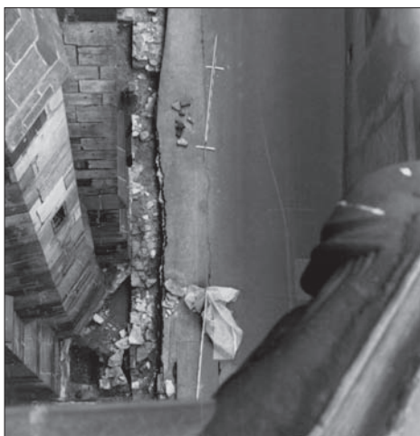
Obr. 75: Vikářská ulice 1994. Severní obvodová zeď ambitu „kláštera kostela pražského“. Foto P. Chotěbor, archiv ARÚ Praha, Pražský hrad.
