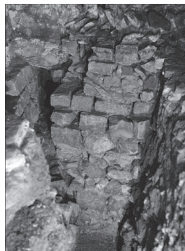
Obr. 106: Čp. 38, sklepy 1966. Východní čelo sklepa. Kvádrkové zdivo interiéru severního křídla „kláštera kostela pražského“ na styku s románskou hradbou (vlevo). Detailní pohled do sondy v základech, archiv ARÚ Praha, Pražský hrad.
