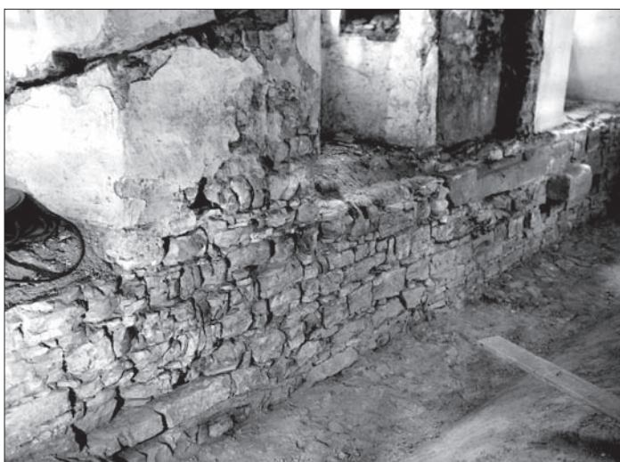
Obr. 111: Čp. 38, přízemí 1967. Vnitřní líc románské kamenné hradby s vloženým pískovcovým žlabem a částí špalety pozdně gotického okna, archiv ARÚ Praha, Pražský hrad.
