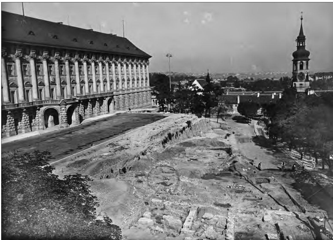
Foto 48: Celkový pohled na zkoumanou plochu od jihu. 7. 10. 1935; č. V4722, č. neg. 73370.
