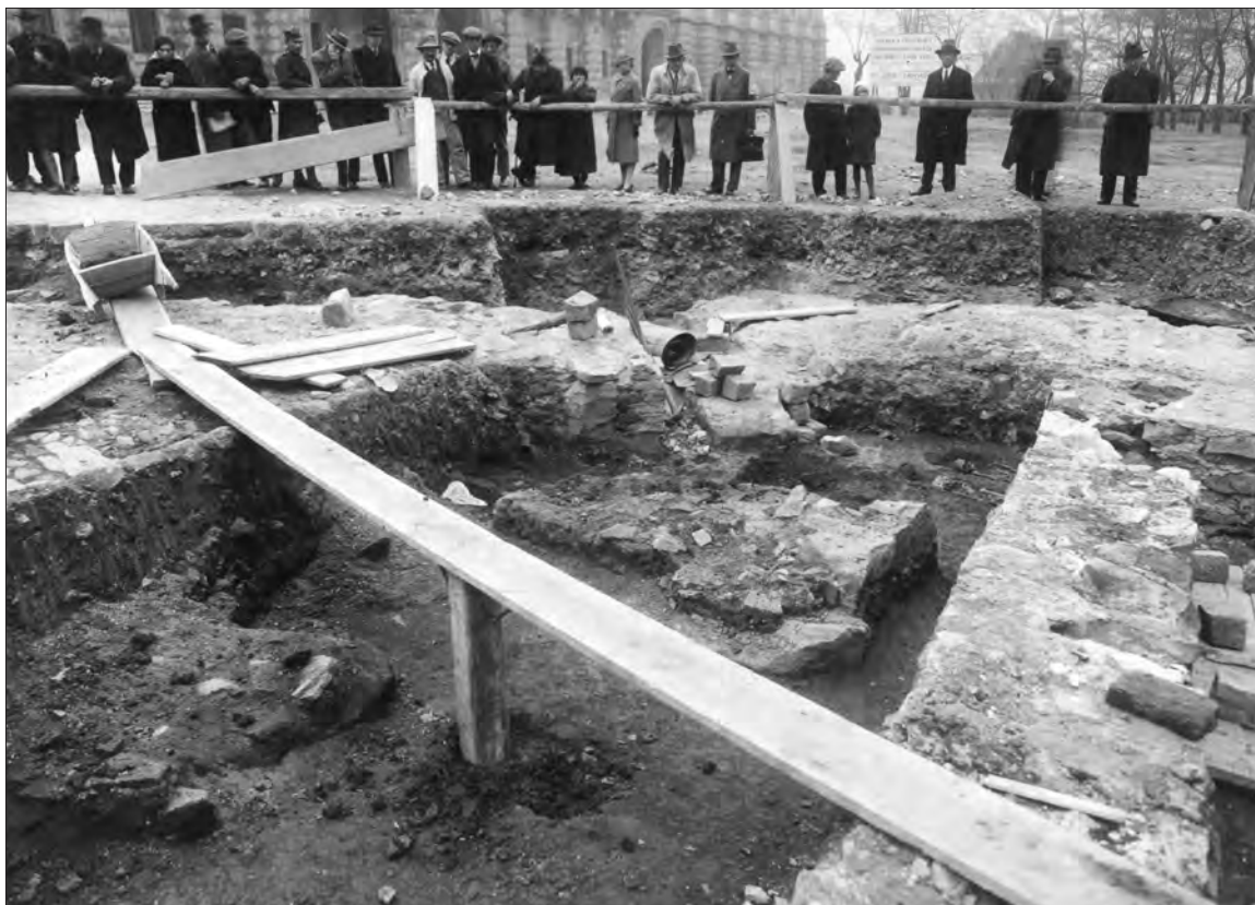
Foto 9: Severozápadní část kaple; pohled od jihu. 29. 3. 1934; č. A8567, č. neg. 73195.
