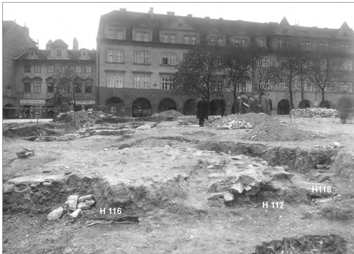
Foto 54: Jižní část S 6, S 4. 29. 4. 1935; č. A9335, č. neg. 73404.
