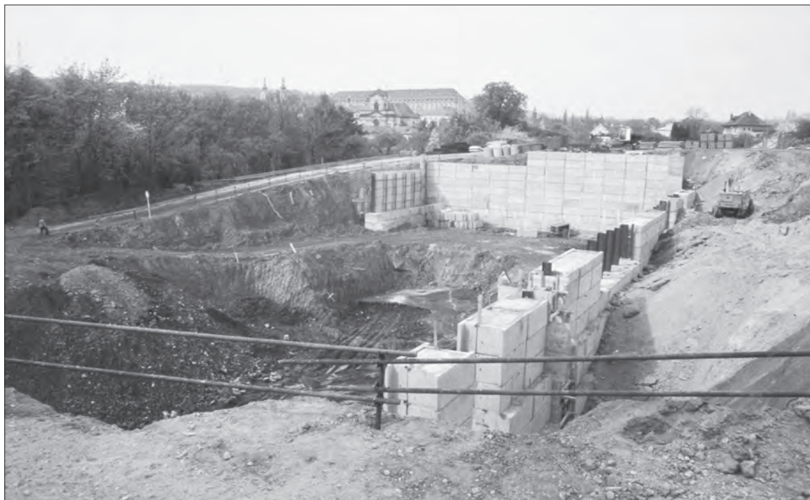
Obr. 19: Praha – Hrad, pohřebiště Lumbeho zahrada 1988. Stavební jáma energocentra. Pohled od východu. Foto J. Frolík.
