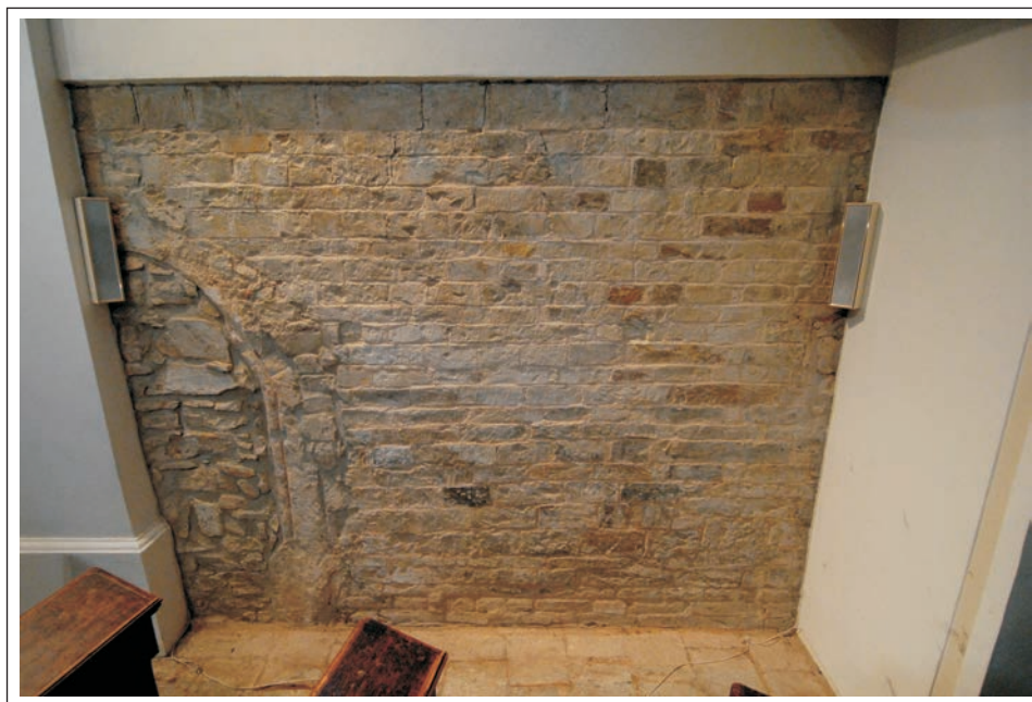
Obr. 3. Praha 8 – Bohnice. Kostel sv. Petra a Pavla. Jižní interiérová zeď románské lodi se zazděným gotickým portálem ve východní partii. Foto M. Tryml.
