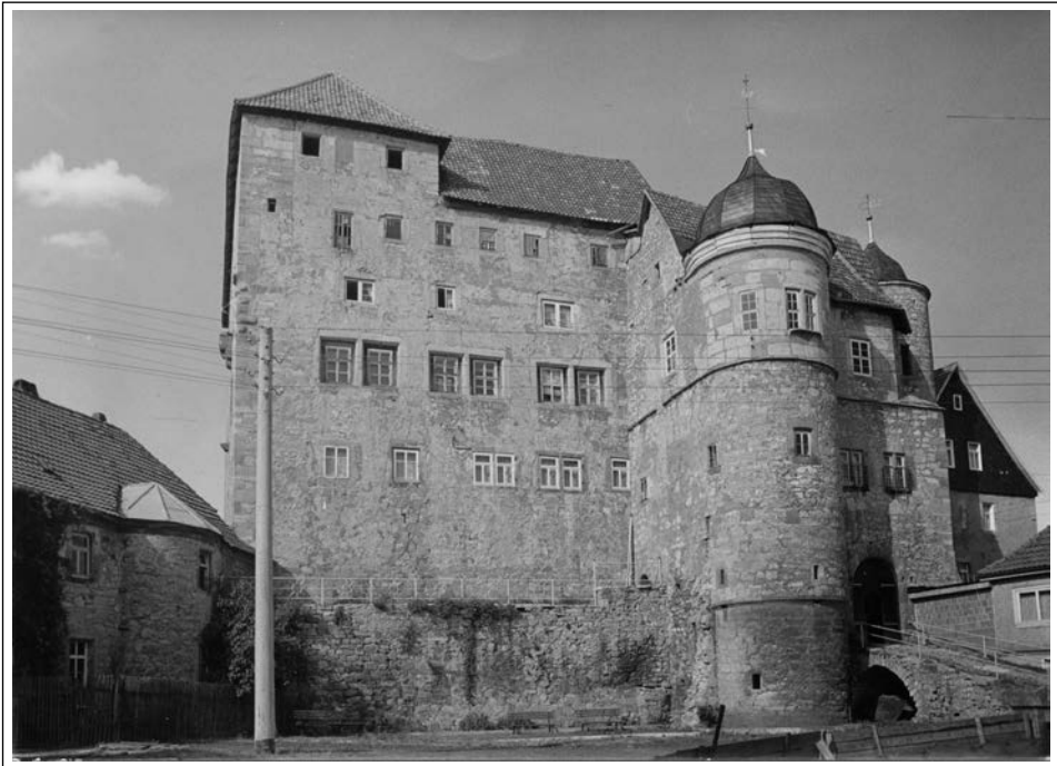
Obr. 3. Pohled na JZ průčelí hradu Kühndorf (foto autor roku 1971).
