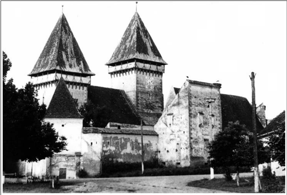
Obr. 13. Loď opevněného kostela v Dealul Frumos (Schönberg, Rumunsko) je sevřena mezi dvěma věžemi a celek obepíná hradba s dalšími věžemi (foto autor roku 1969).
