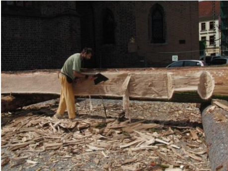
Obr. 42 a) Lícování, b) tlakové dřevo smrku
