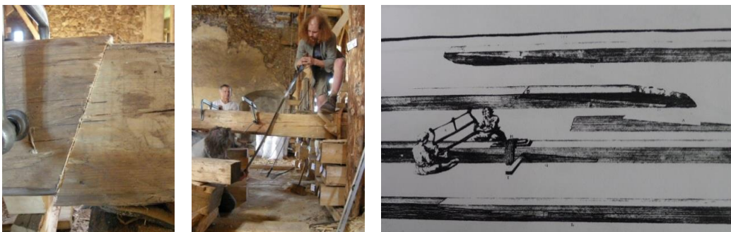
Obr. 33 a) Spasování čela spoje, b) prořezávání ruční pilou c) prořezávání čel spoje v díle [19]
