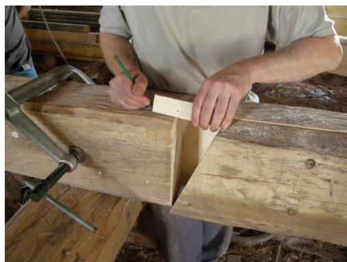
Obr. 30 Orýsování šikmé čela z již zaříznutého protikusu
