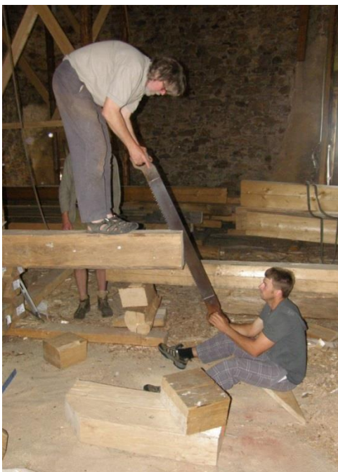
Obr. 22 Řezání podélného plátu pomocí tesařské řetězové pily
