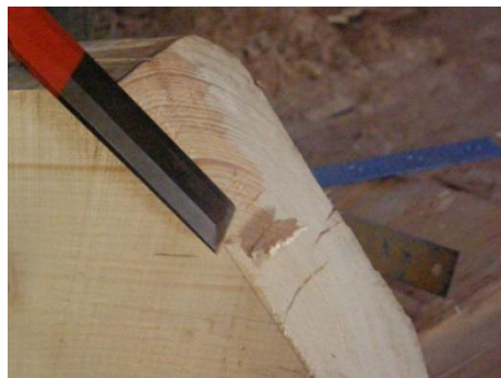
Obr. 32 Osekání nadbytečné délky plátu
