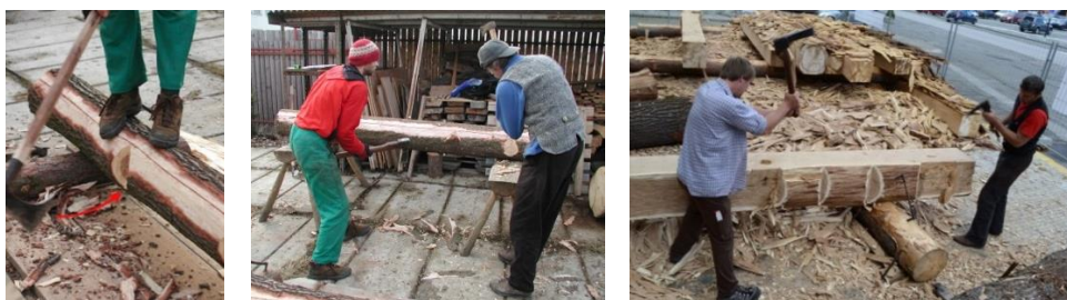
Obr. 41 Vrubování (vlevo, uprostřed) [16], hrubování (vpravo)
