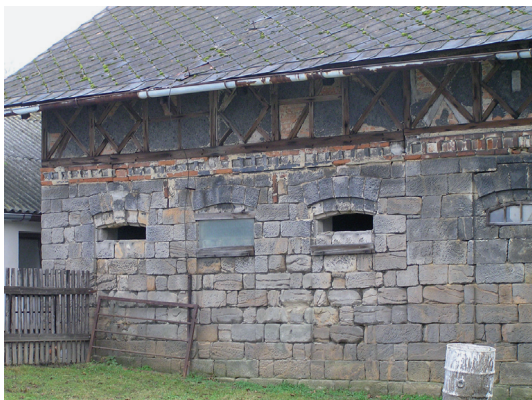
Obrázek 32. Kněžnice, okres Jičín – zadní hospodářská část domu provedená z kamenných kvádrů a hrázděné zdiva, použitého na půdní nadezdívky později překryté falešným hrázděním
