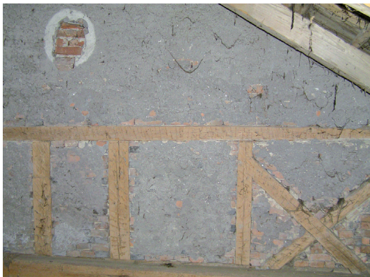
Obrázek 33. Kněžnice, okres Jičín – štít nad hospodářskou částí domu, provedený z části jednoduchou hrázděnou technikou a výplněmi z pálených cihel, jen hrubě nahozených s ohledem na charakter prostoru
