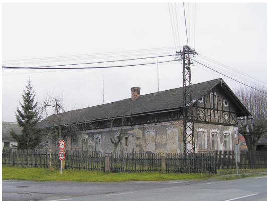
Obrázek 31. Kněžnice, okres Jičín – celkový pohled na zděný dům s brázděnou konstrukcí štítu a půdních nadezdívek
