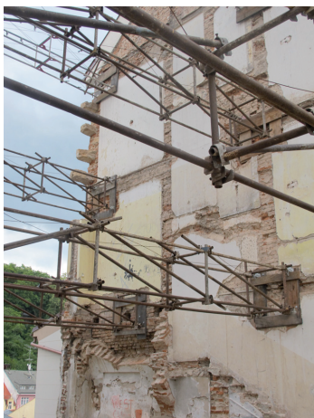
Obrázek 14. Karlovy Vary – rozeptření štítových stěn příhradovými nosníky sestavenými z lešenářských trubek
