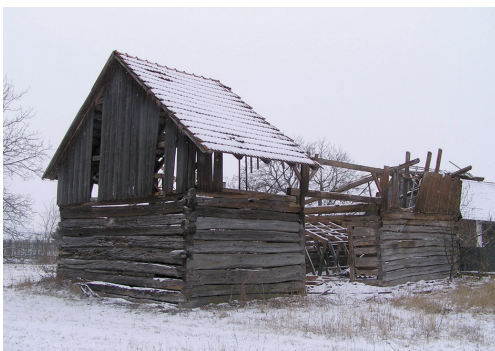
Obrázek 19. Sovenice, okres Nymburk - příklad destrukce roubené hospodářské stavby
