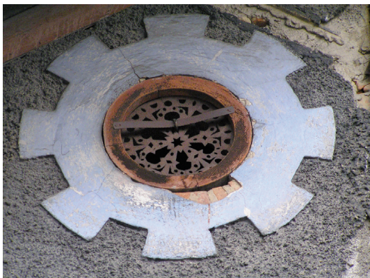
Obrázek 34. Kněžnice, okres Jičín – kruhový větrací otvor ve štítě domu, opatřeného mladším typem povrchové úpravy kombinující hladkou a hrubou omítku
