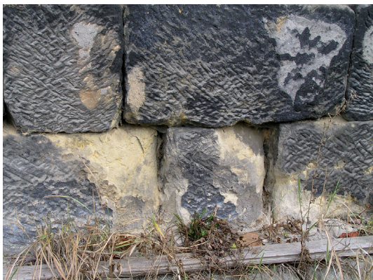
Obrázek 38. Kněžnice, okres Jičín – kamenné kvádry použité na podezdívku a vystavené zvýšenou měrou účinkům vztlínající vlhkosti i vlhkosti z terénu. Nejvíce narušené bývají zpravidla kvádry níže položené, vystavené i možnému mechanickému poškození
