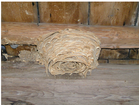
Obrázek 45. Kněžnice, okres Jičín – půdní prostor, ve kterém se usídlil hmyz prozrazený hnízdem umístěným při vrcholové vaznici
