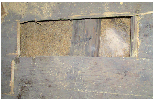
Obrázek 42. Kněžnice, okres Jičín – sonda v prkenné podlaze podkrovního prostoru umožňující v důsledku částečného odstranění záklopu prohlídku stropní konstrukce
