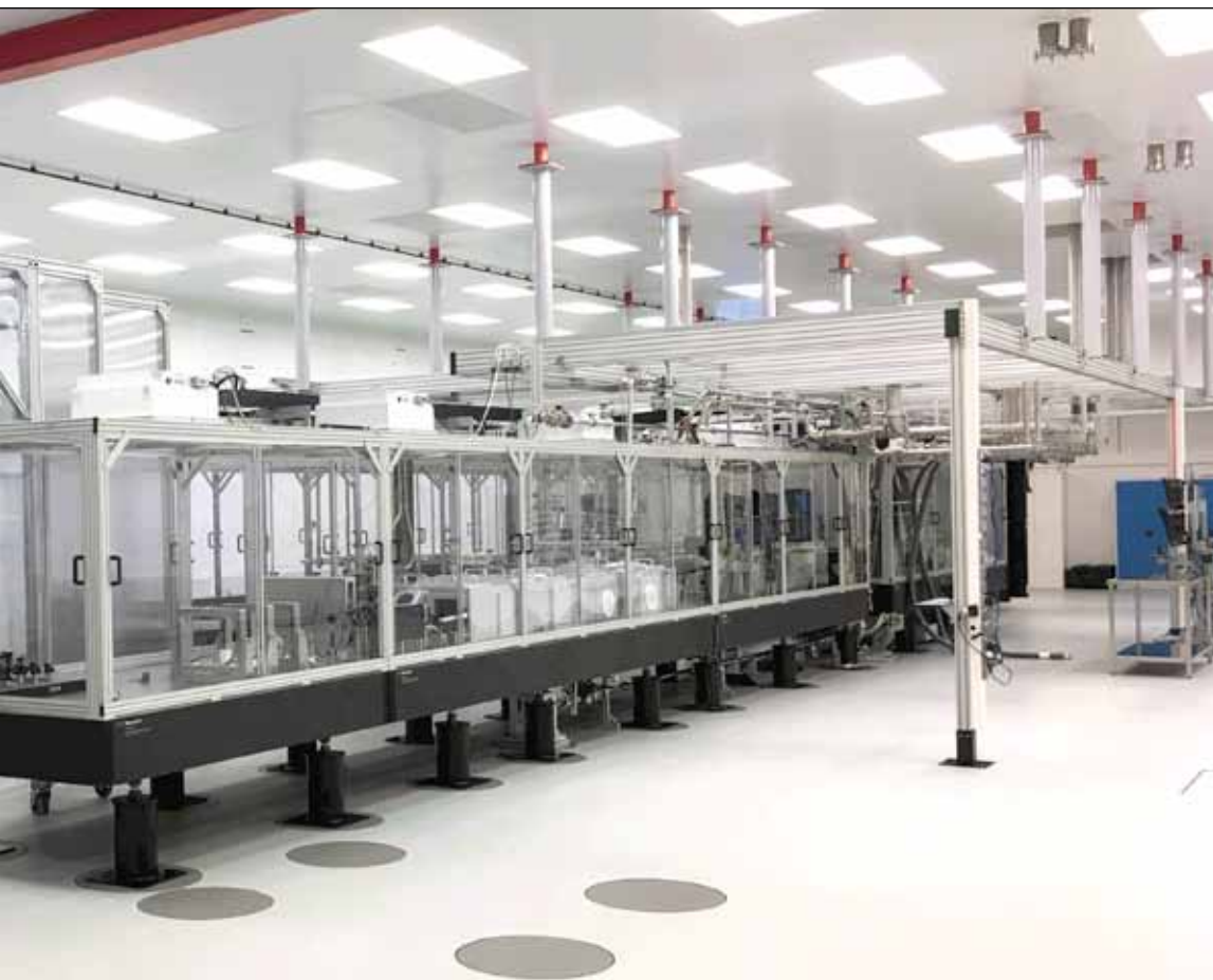
Laserový systém L3 při instalaci a spouštění
