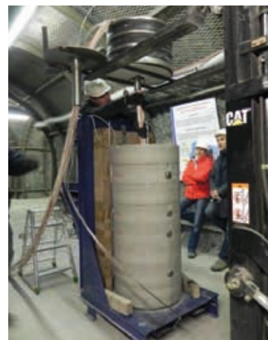
Konstrukce těsnícího systému sestaveného z osmi bentonitových bloků. Construction of a sealing system made up of eight bentonite blocks.
