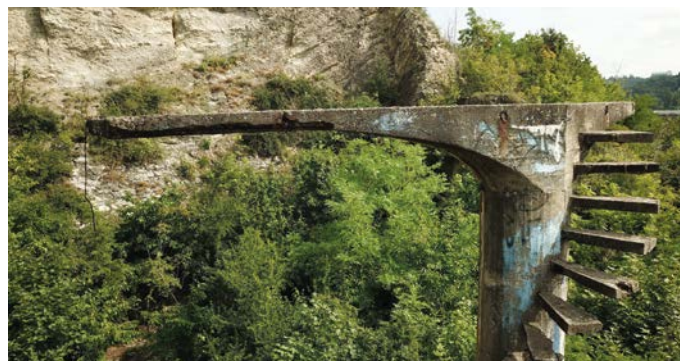
Obr. 2. Detail aktuálního stavu horní plošiny skokanského můstku (fotografie pořízená dronem).
