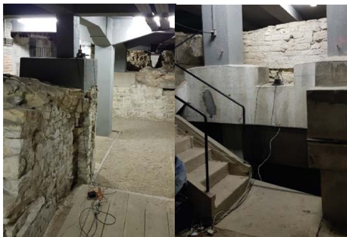
Obr. 4 Pohled na snímače zrychlení v měřených bodech.
