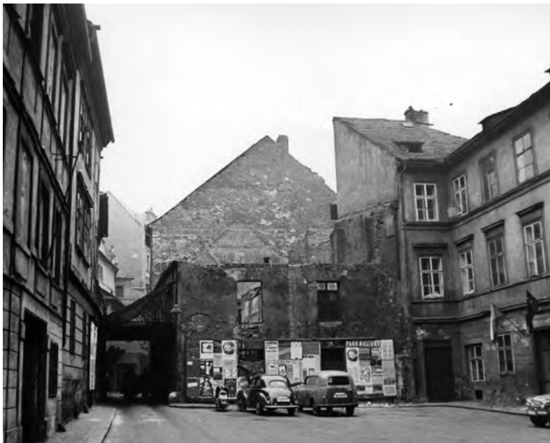
Obr. 29. Pohled do Jilské ul. s domy čp. 361 (uprostřed) a čp. 236 (vpravo). Stav před rekonstrukcí. Datace přibližně r. 1964. (Správa budov AV ČR)
