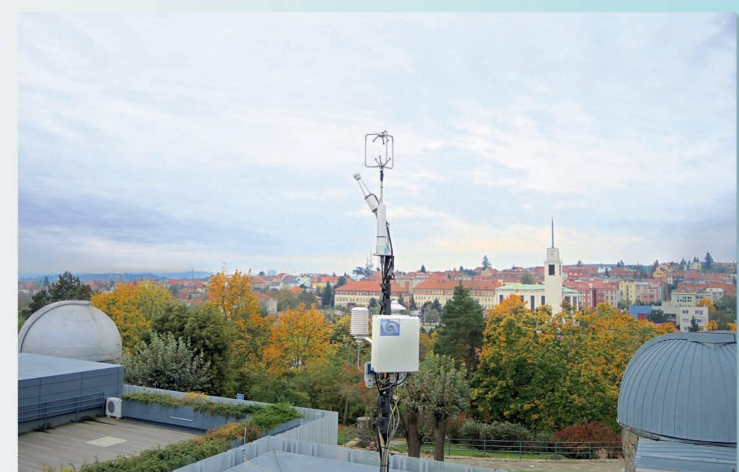
Nová měřicí stanice umístěná na střeše Hvězdárny a planetária Brno sleduje výměnu CO 2 mezi urbánním ekosystémem a atmosférou
