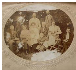
Fotografia dopo un'allagamento.
