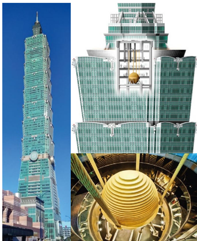
Obr. 1. Pohled na mrakodrap Tchaj-pej 101, svislý řez jeho konstrukcí v místě instalace pohlcovače a reálné foto absorbéru. Zdroj: Someformofhuman/Creative Commons
