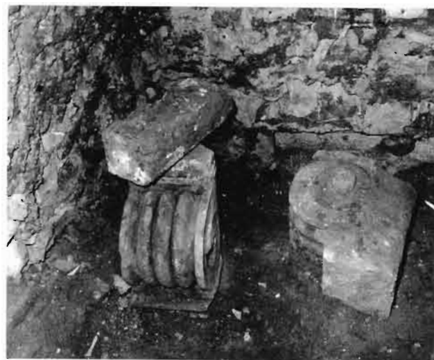
Obr. 69: Konzoly portálového ostění z pískovce, nalezené v suterénu jihovýchodního křídla. Foto J. Sloup.
