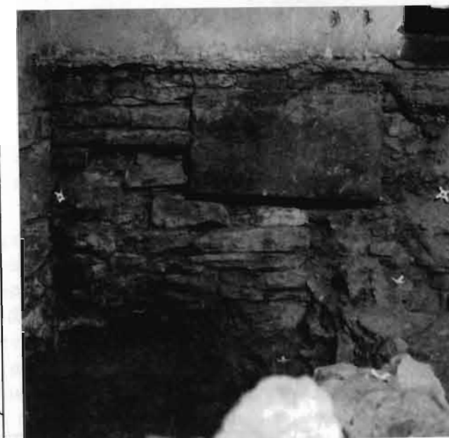
Foto 11: Čp. 48, sonda VI. Pohled na jižní zeď místnosti. Dole základ a dva řádky zdiva domu I, jež se uprostřed lomí směrem k jihu (dozadu). Na něm nazděno zdivo domu III. Pískovcový kvádr je patkou dodatečně vloženého gotického ostění. Foto J. Morávek. Negativ z archivu Útvaru technické dokumentace ARÚ AV ČR Praha.
