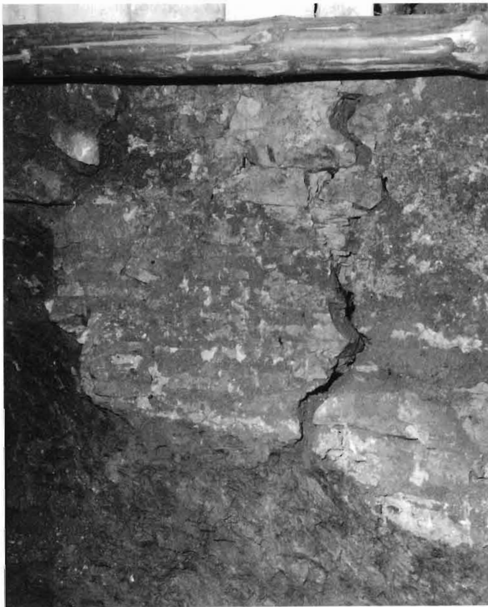
Obr. 11: Část základových partií vnějšího líce malostranské hradby. Foto J. Sloup.
