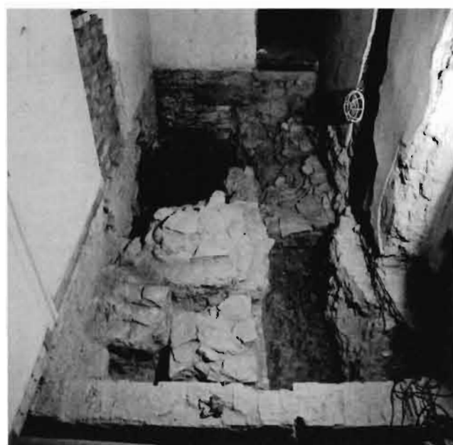
Foto 10: Čp. 48, sonda VI. Celkový pohled od severu. V popředí za recentní cihlovou zdí část západní zdi domu II, do níž je vložen pilíř, pravděpodobně ze starší fáze přístavku 2. Vlevo předzáklad západní zdi přístavku 1. Vpravo vzadu blok zdiva v místech vstupu (?) do domu II, poškozený vrcholně středověkou odpadní jamou (vlevo vzadu). Č. neg. 74127.
