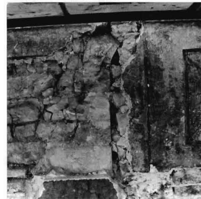
Foto 6: Čp. 48. Severní stěna v úrovni 1. patra. Fragment okna v severní zdi přístavku 1. Vlevo struktura románského zdiva, narušená požárem v r. 1541. Č. neg. 74187.
