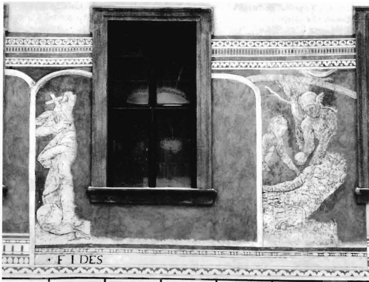
Obr. 68: Nejzachovalejší část sgrafitové figurální výzdoby (nejmladší vrstva sgrafita) v průčelí dělicího křídla do velkého nádvoří. Vlevo od barokního okna fragment postavy Víry, vpravo fragment větší figurální scény (Paridův soud?), římsa nad oběma fragmenty pochází ze starší sgrafitové vrstvy. Foto J. Kopriva.
