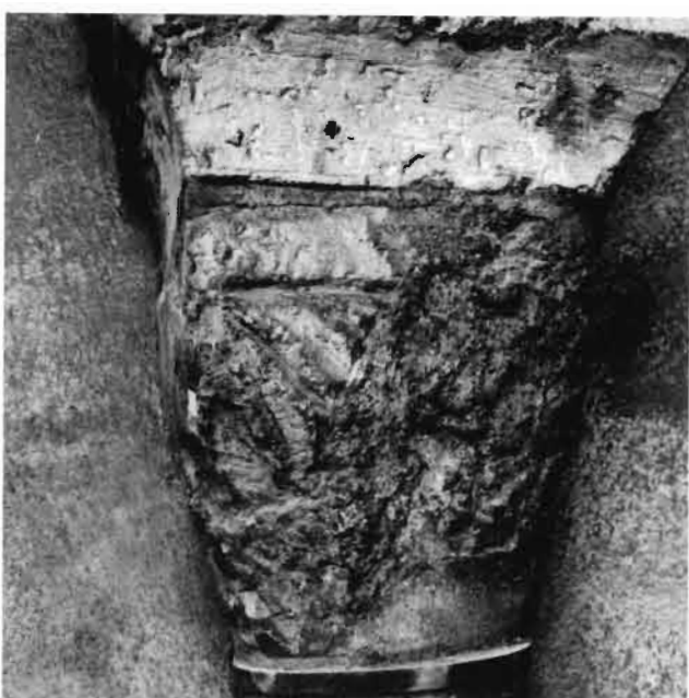
Foto 5: Čp. 48. Východní stěna v úrovni 2. patra. Sdružené okno domu III, detail hlavičky. Č. neg. 74180.
