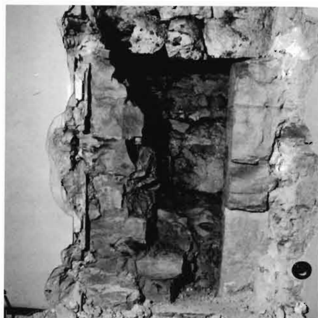
Foto 3: Čp. 48. Střední dělicí chodba v úrovni 1. patra. Část okna v severní zdi domu III. Dochována pravá špaleta z opukových kvádrů a překlad z červeného pískovce. V okně zazdívká, jež je pozůstatkem západní obvodové zdi přístavku 1. Č. neg. 74200.
