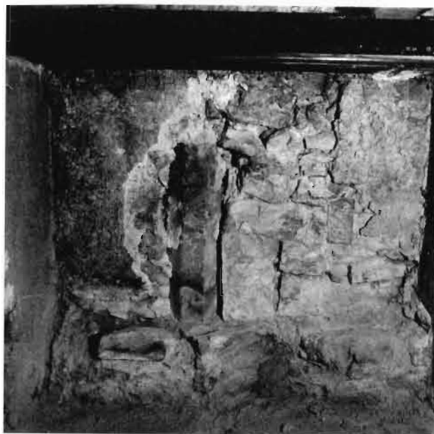
Foto 2: Čp. 48. Střední dělicí chodba v přízemí, severní zeď. Osmiboký(?) sloupek z červeného pískovce, druhotně(?) užitý v severní zdi domu III. Č. neg. 74196.
