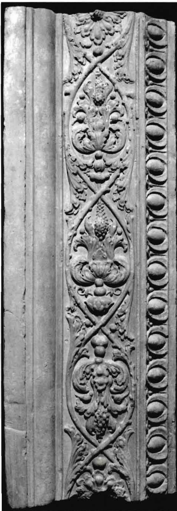
Obr. 39: Terakotový díl ostění velkého okna (typ V). Snímek J. Kopřiva.
