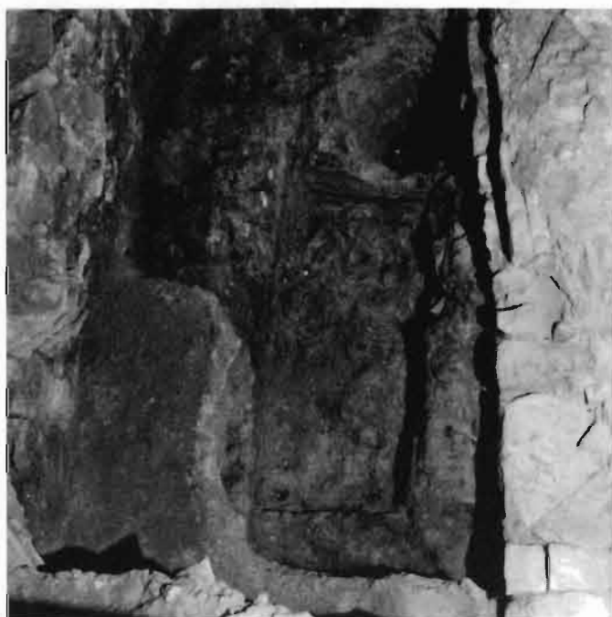
Foto 7: Čp. 48, sonda III. Objekt 1 - dřevem vyložená schránka, vykopaná do podloží. Vpravo zeď domu II, vlevo předzáklad přístavku 1. Pohled shora od severu. Č. neg. 74058.
