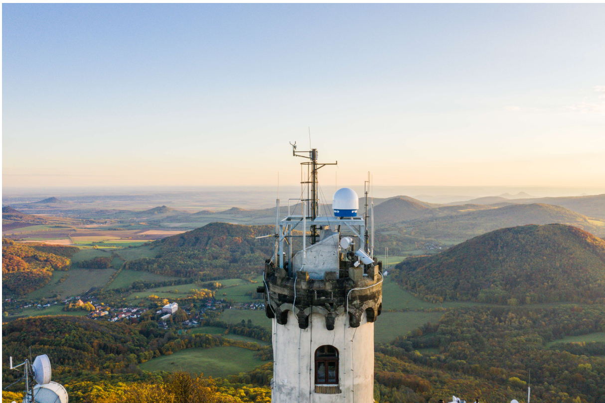
Obr. 1: Na vrcholu vyhlídkové věže je umístěn X-pásmový polarimetrický radar FURUNO 2010.
