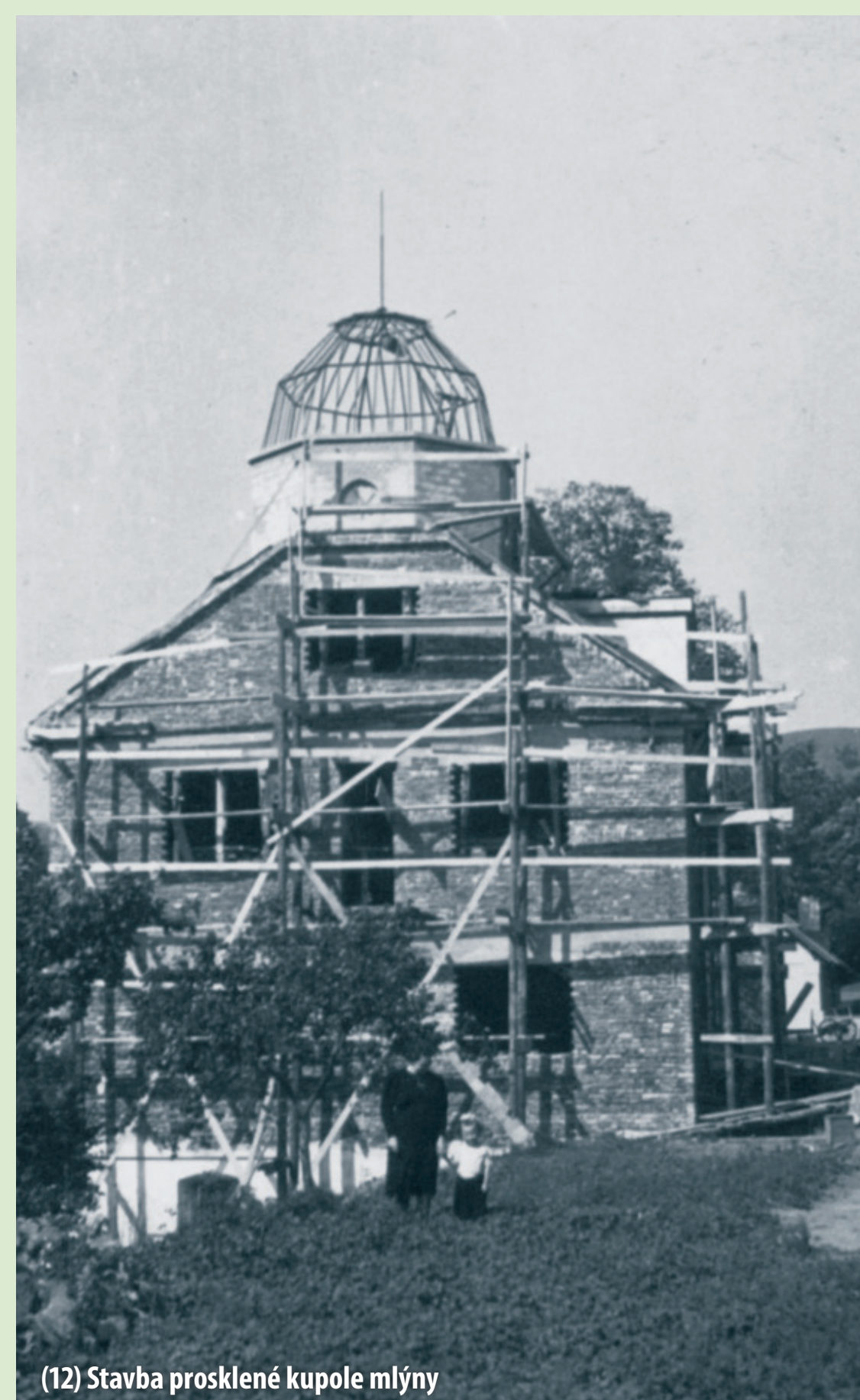
(12) Stavba prosklené kupole mlýny
