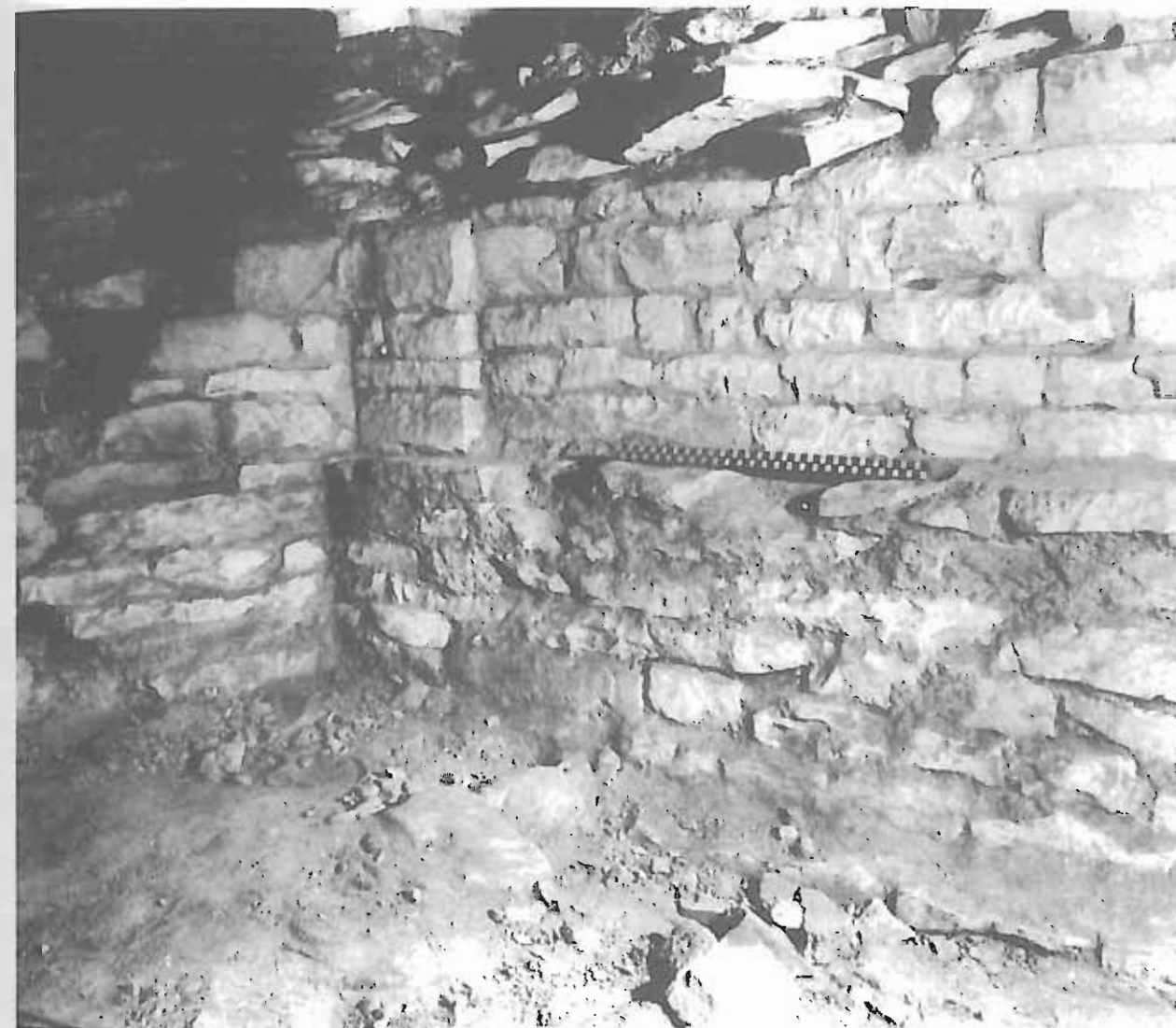
Obr. 4/41: Chrám sv. Víta, kaple sv. Václava. Pohled na vnější líc vnějšího prstence zdiva na západní straně jižní apsidy. Patrné rozhraní základového a nadzemního zdiva s lizénou v místě připojení apsidy na loď rotundy. Patrný dochovaný celý rozsah líce lodě, a to v základové (fáze 1) i nadzemní (fáze 3A) části. Pohled od jihozápadu.
