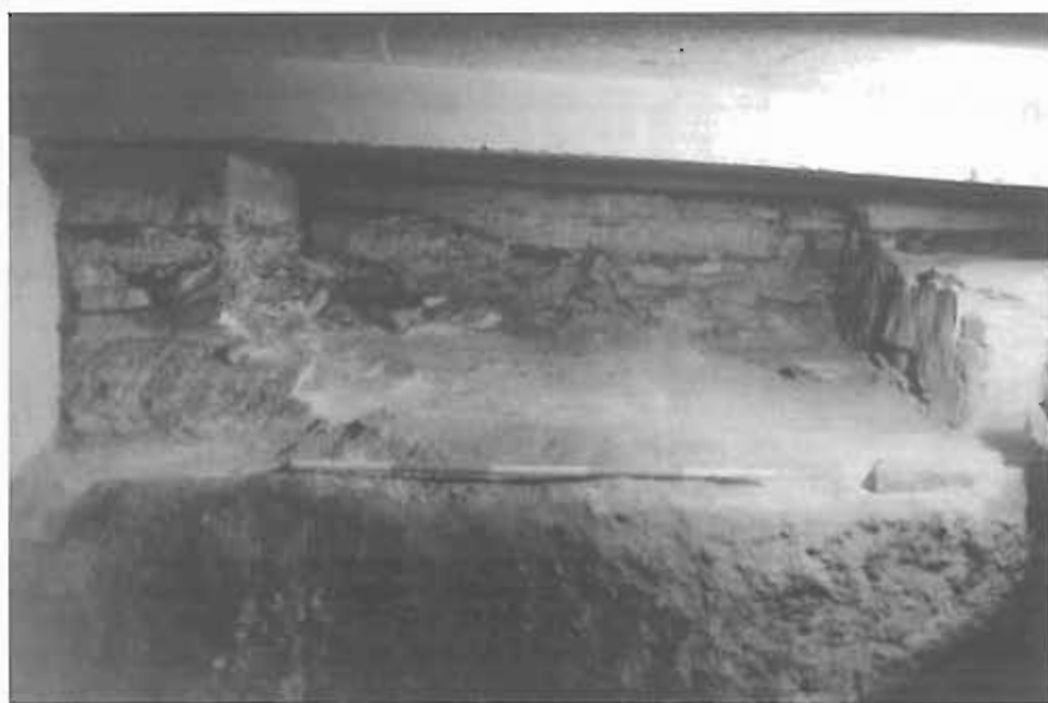
Obr. 4/48: Chrám sv. Víta, kaple sv. Václava. Pohled do severní části interiéru jižní apsidy. Vpravo vnitřní nároží vnitřního prstence zdiva na západní straně apsidy (fáze 2A), pokryté mladší maltou (fáze 4B). Vlevo blok zdiva, nahoře zakončený pískovcovým kvádrem – základ gotického oltáře u hrobu sv. Václava. V základu zbytek zdiva lodí rotundy (etapa 1). Vzádu základ pro náhrobek sv. Václava, před ním maltová podlaha v interiéru apsidy. Hrana v popředí je jižní stěnou hrobové jámy hrobu K1. Pohled od severu.
