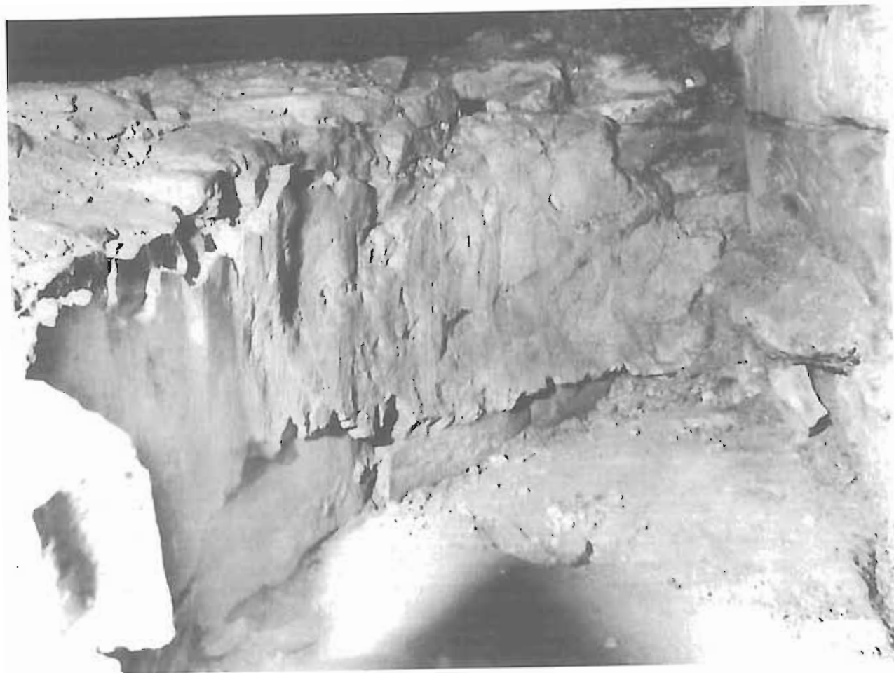
Obr. 4/44: Chrám sv. Víta, kaple sv. Václava. Pohled do jižní části jižní apsidy. Vnitřní líc vnitřního prstence zdiva pokrytý mladší maltou. Vpředu část původní maltové podlahy. Vpravo zdivo gotického hrobu sv. Václava. Pohled od východu.
