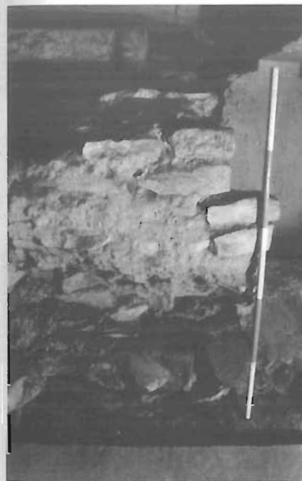
Obr. 4/46: Chrám sv. Víta, kaple sv. Václava. Pohled na severní zakončení vnitřního prstence zdiva od východu. Dole patrný nepravidelný, patrně ubouraný líc (tj. zdivo by pokračovalo směrem dopředu – k fotografovi, fáze 2A), na něm blok zdiva, oddělený ústupkem (patrným vpravo), zbytek oltáře 12 apoštolů (fáze 3B). Pohled od východu.
