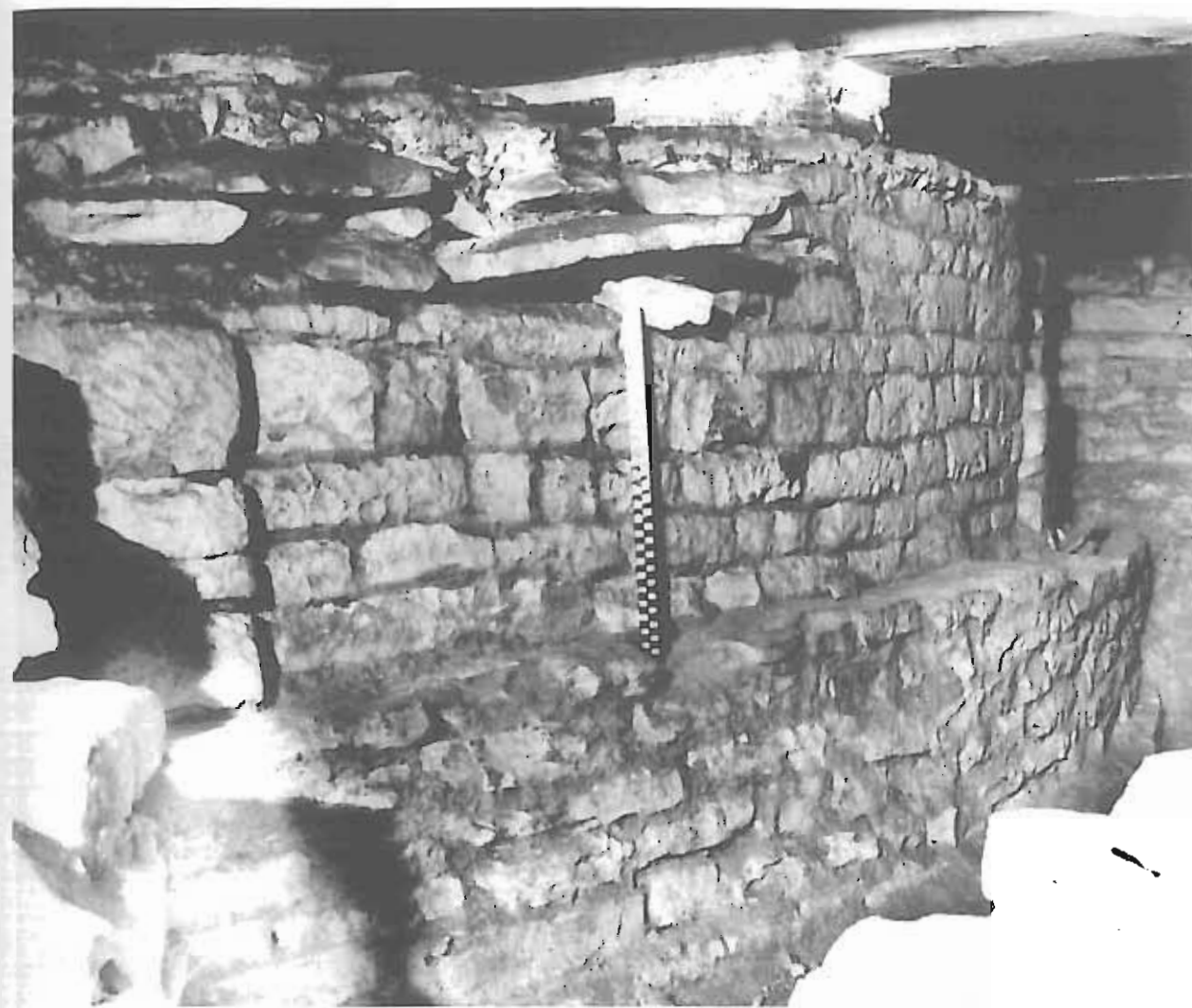
Obr. 4/39: Chrám sv. Víta, kaple sv. Václava. Pohled na vnější líc vnějšího prstence zdiva na západní straně jižní apsidy. Patmo dvakrát odstupněné základové zdivo a zdivo nadzemní se dvěma lizénami. Vzaďu část zdiva jižní obvodové zdi jižní lodi románské basiliky. Pohled od severozápadu. obr. 4/39 až 4/44 fotografoval K. Musial.
