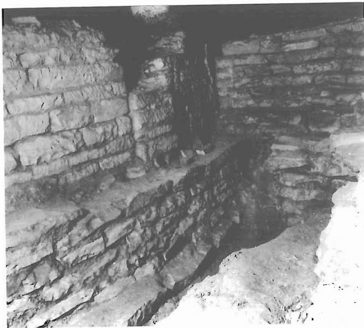
Obr. 4/40: Chrám sv. Víta, kaple sv. Václava. Pohled na vnější líc vnějšího prstence zdiva na západní straně jižní apsidy. Patrný dvakrát odstupněný základ a nadzemní zdivo s lizénou. Vzadu přizdána mladší zeď jižní obvodové zdi jižní lodě románské baziliky s patným rozhraním mezi základovým a nadzemním zdívem. Pohled od severozápadu.
