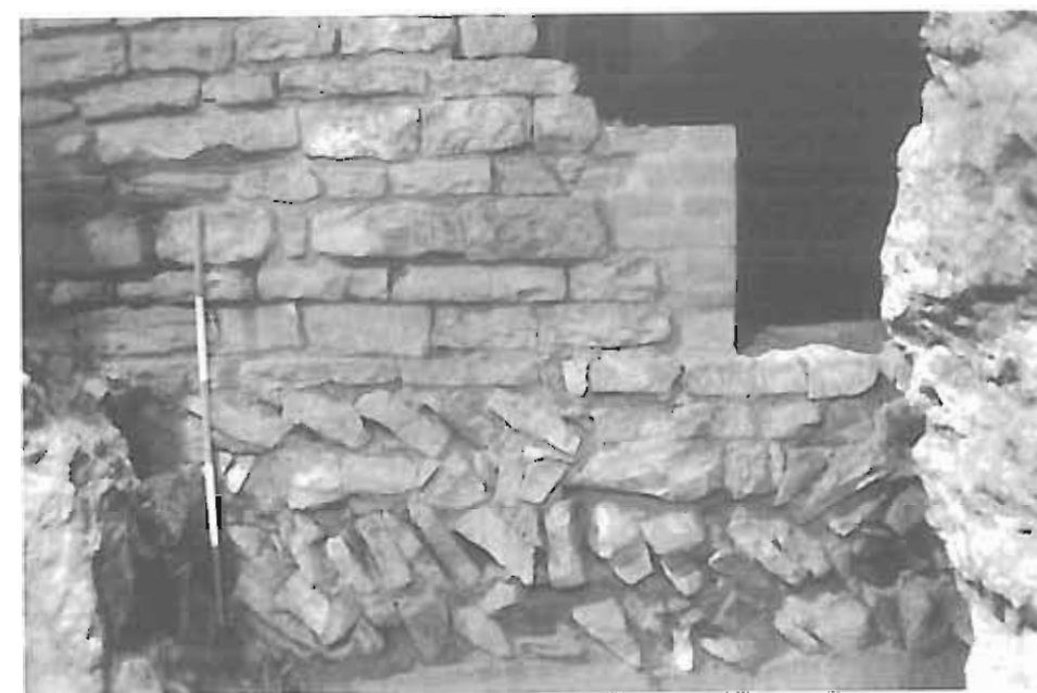
Obr. 2/44: Praha – Hrad, kostel P. Marie. Výzkum v roce 1995. Vnější líc západní zdi lodi kostela. Pohled od západu. Č. neg. 90149.
