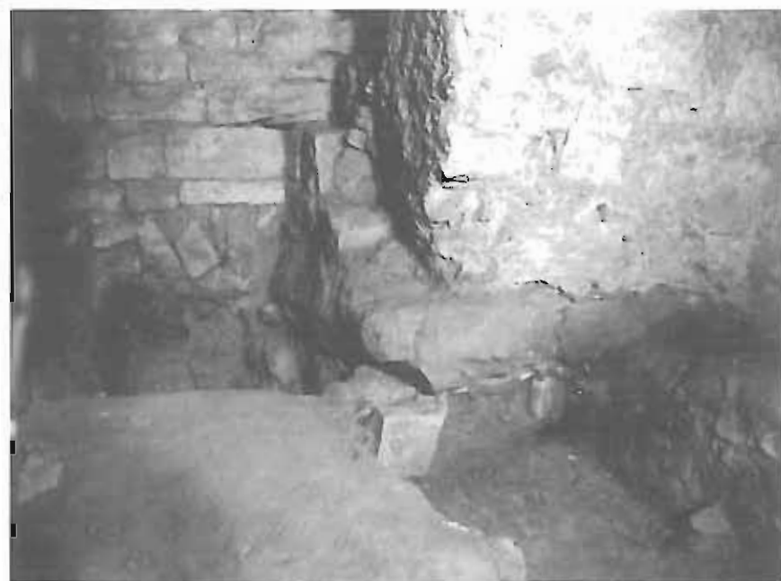
Obr. 2/42: Praha – Hrad, kostel P. Marie. Výzkum v roce 1995. Severovýchodní nároží lodi kostela a přiléhající část zdiva apsidy. Spodní dvě řady kamenů v nároží kostela jsou pozůstatkem zdiva staršího kostela. Pohled od severovýchodu. Č. neg. 90126.
