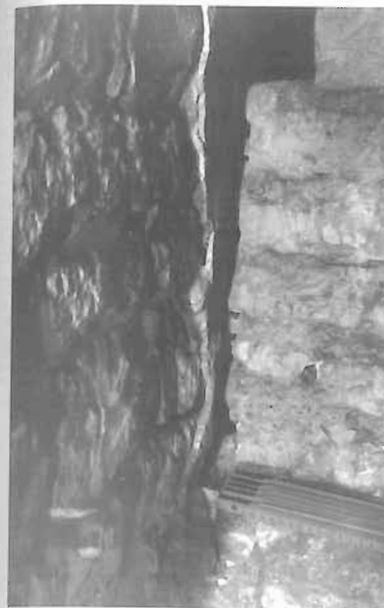
Obr. 4/49: Chrám sv. Víta, kaple sv. Václava. Detail přizdění jižní obvodové zdi jižní lodí románské baziliky (vpravo) na omítnutou stěnu jižní apsidy rotundy, konkrétně na západní (vnější) stěnu vnějšího prstence. Pohled od severu.
