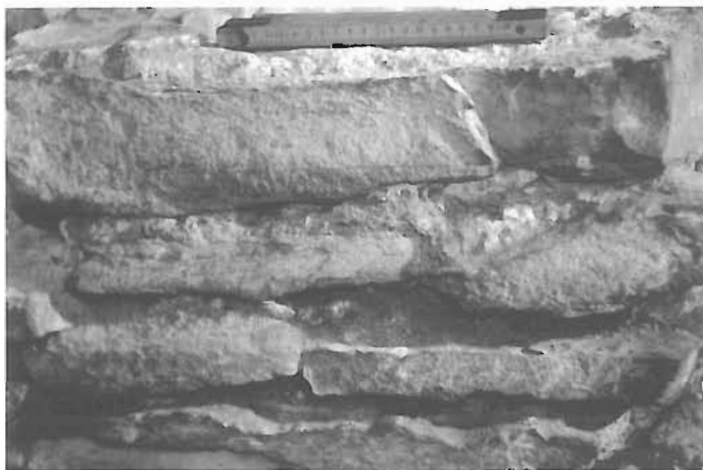
Obr. 4/52: Chrám sv. Víta, kaple sv. Václava. Detailní pohled na vnější líc vnitřního prstence zdiva jižní apsidy na jižní straně východního ramene. Nadzemní část zdiva. Pohled od východu.
