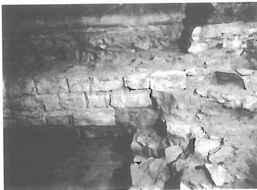
Obr. 3/24: Praha – Hrad, chrám sv. Jiří. Hlavní loď, západní krypta. Pohled na zdivo v severo-východním rohu krypty. Patrný ubourané stupně schodiště. Pohled od jihu. 28. 5. 1959. Č. neg. 2079/66588, foto I. Borkovský.
