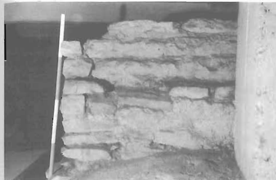
Obr. 4/46: Chrám sv. Víta, kaple sv. Václava. Pohled na severní zakončení vnitřního prstence zdiva od východu. Dole patrný nepravidelný, patrně ubouraný líc (tj. zdivo by pokračovalo směrem dopředu – k fotografovi, fáze 2A), na něm blok zdiva, oddělený ústupkem (patrným vpravo), zbytek oltáře 12 apoštolů (fáze 3B). Pohled od východu.
