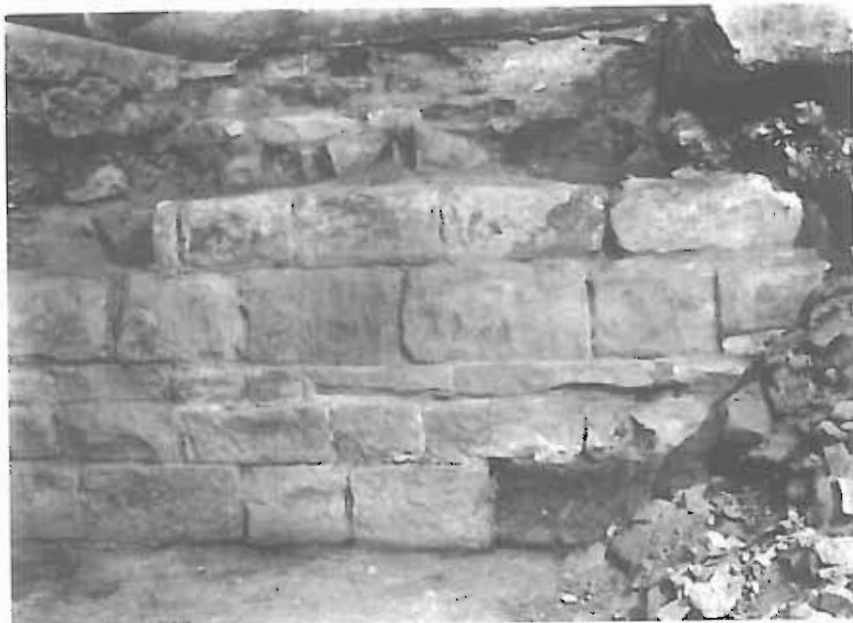
Obr. 3/23: Praha – Hrad, chrám sv. Jiří. Hlavní loď, západní krypta. Pohled na střední část vnitřního líce severní zdi krypty. Pohled od jihu. 20. 3. 1959. Č. neg. 2047/66556, foto I. Borkovský.
