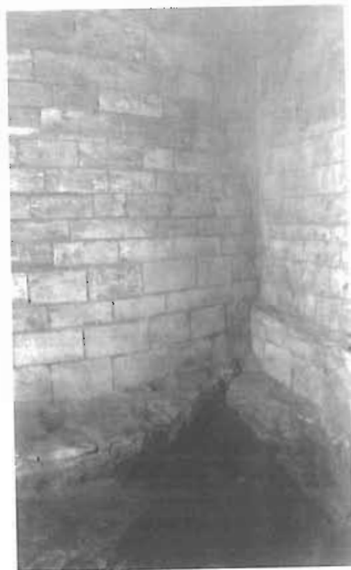
Obr. 3/26: Praha – Hrad, chrám sv. Jiří. Prostor pod kaplí sv. Ludmily. Pohled na styk zdiva východní krypty (vpravo) a apsidy jižní boční lodi. Spodní část zdiva apsidy nasedá na ústupek ve spodní části zdiva krypty. Pohled od východu. 11. 5. 1960. Č. neg. 2304/65546, foto I. Borkovský.
