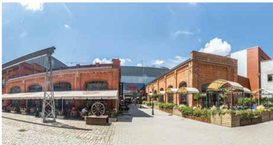
Galerie Vaňkovka se nachází v širším centru města Brna, nedaleko hlavního vlakového nádraží. V roce 1992 se stala kulturní památkou a o dva roky později dokonce vznikla nadace pro záchranu a nové využití areálu. Revitalizace bývalé továrny započala v roce 2000.
