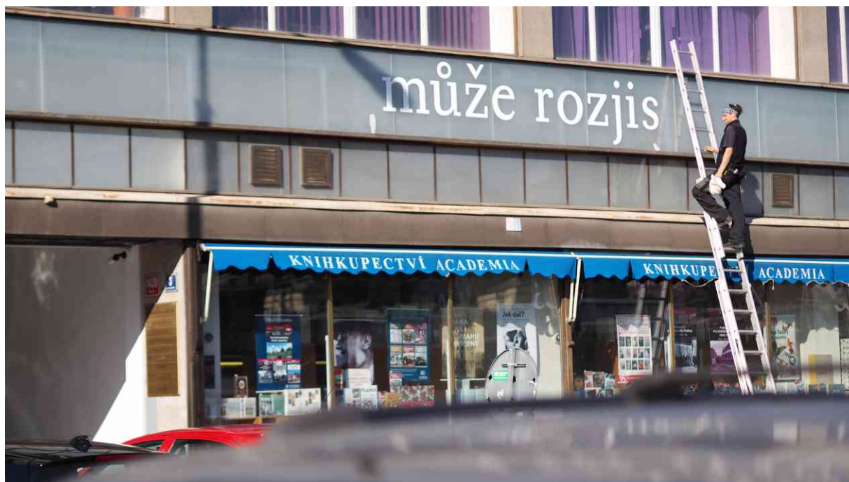
OBR. 26: Instalace citátu O. Březiny na průčelí pražské budovy ÚČL; zdroj: ÚČL
