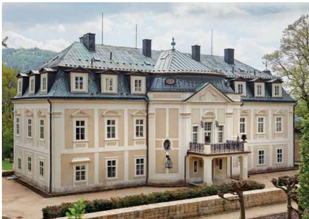
Zámek Malá Skála, severní průčelí, 2019
