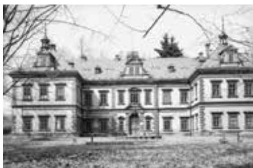
Zámek Jilemnice, hlavní průčelí v roce 1953
