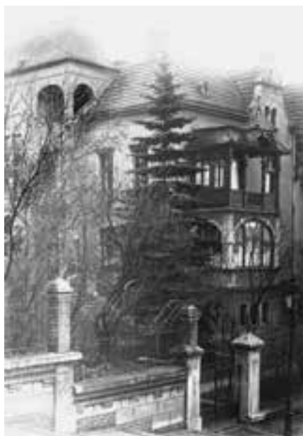
Vila v Dvořákové ulici čp. 22, v níž Pifflovi při pobytu v Ústí nad Labem bydleli. A. Piffel zde zřídil sběrnou kulturně hodnotného mobiliáře zajištěného z konfiskovaného majetku ústeckých Němců
