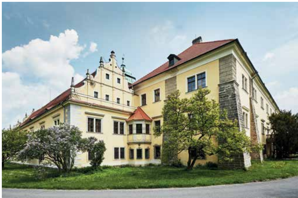
Zámek v Doksech, pohled na západní a jižní křídlo v roce 2018
