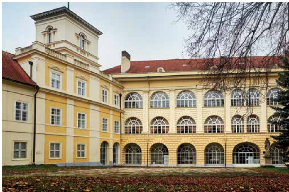
Teplice, nádvoří zámku v roce 2016
