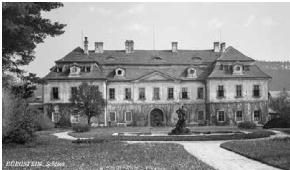
Zámek Sloup v Čechách, pohled na zahradní průčelí, před rokem 1945
