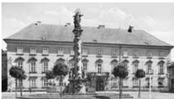
Zámek Mímoň, hlavní průčelí, 1. polovina 40. let
