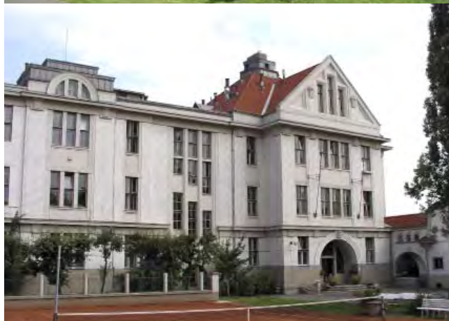
FZÚ AV ČR – pracoviště Cukrovarnická 10 v Praze 6
