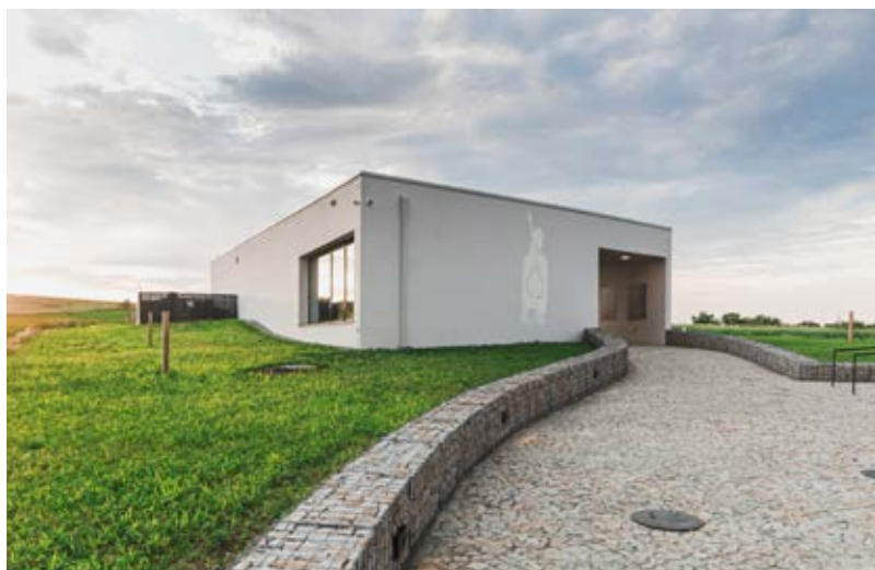
Exteriér budovy Návštěvního centra Mušov – Brána do Římské říše. Zdroj: archiv ARÚB.
