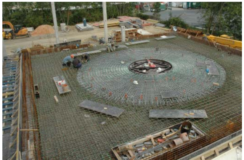
Část armování pod tokamakem je z nemagnetické oceli a veškeré armování je vzájemně elektricky izolováno, aby nevytvářelo uzavřené vodivé smyčky. (foto: F. Jiránek)
