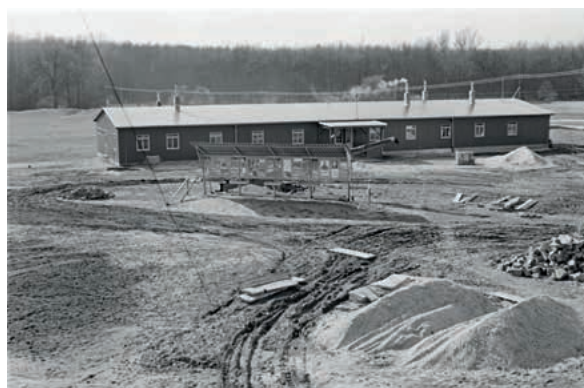
27 Již v roce 1956 vznikla dřevěná montovaná stavba, která plnila účel hlavní budovy archeologické expedice až do tragického požáru v roce 2007.
