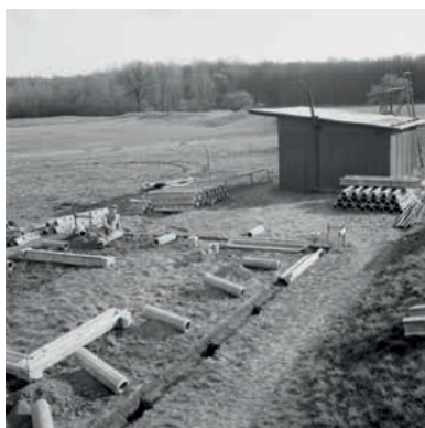
25 Dřevěná bouda z roku 1954 jako první objekt archeologů. K ní hned v následujícím roce přibyl „bílý dům“, jehož bodově zahloubené základy (v popředí) měly zajistit co nejšetrnější zásah do archeologických vrstev.
