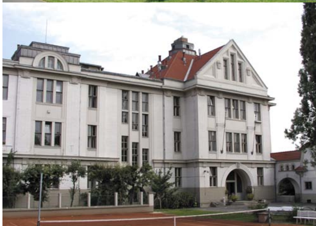
FZÚ AV ČR – pracoviště Cukrovarnická 10 v Praze 6
