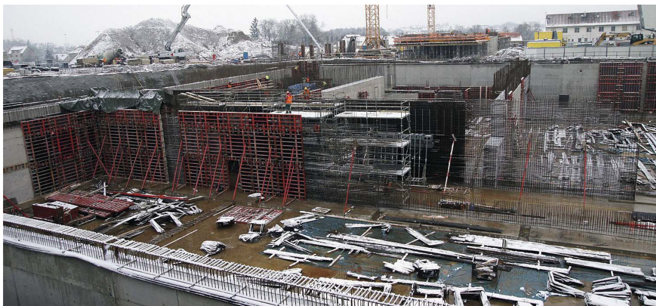
■ Obr. 4 Staveniště ELI Beamlines v Dolních Břežanech. Rozestavěné stěny experimentálních hal E1, E2, E3 (zadní řada zleva doprava) a E5 (na obrázku vpředu) jsou již patrné. Budova bude uvedena do provozu v roce 2015.
