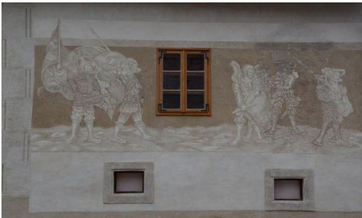
Sgrafitová výzdoba fasády domu č. p. 545 ve Slavonicích po doplnění chybějících částí navržených jako kopie s využitím původních materiálů a technologií.
