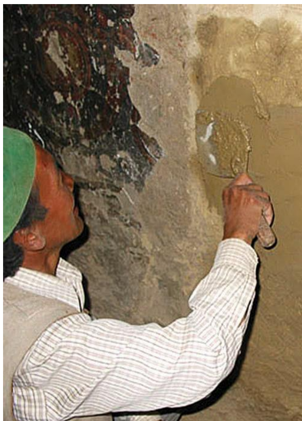
Doplňování chybějící omítky směsí připravenou podle tradiční receptury
