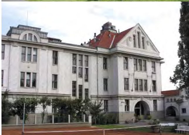
FZÚ AV ČR – pracoviště Cukrovarnická 10 v Praze 6
