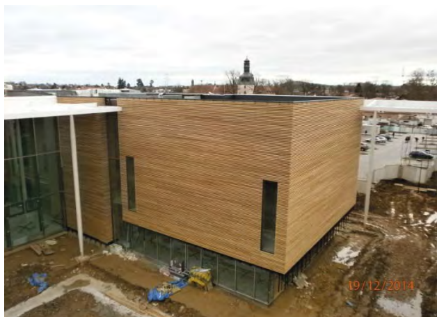
■ Obr. 14 Stav výstavby ELI Beamlines koncem roku 2014.
