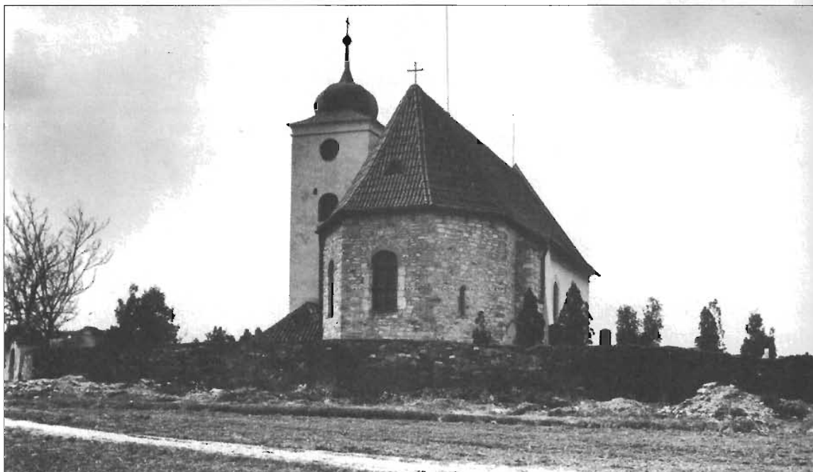
Obr. 101: Kostel sv. Klimenta s gotickým presbytářem. Malé okénko pravděpodobně pochází z ubourané části rotundy, velká okna (13. stol.?) byla znovu upravována při barokní přestavbě kostela v 17. stol.
