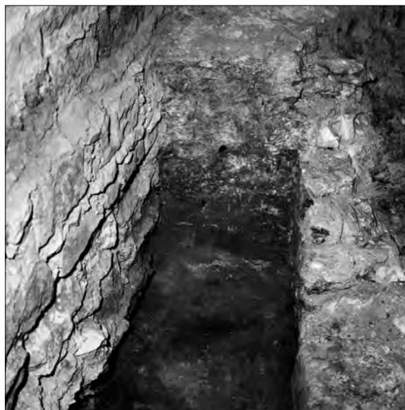
Obr. 3: Odpadní jímka ve sklepe domu čp. 34/IV; pohled od severu
