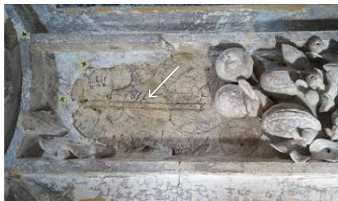
4 Podklad transferované části klenebního žebra s výraznou dvojlínkou rozvrhu žeber. Štuková výzdoba ve středu klenby v hlavním společenském sále.
