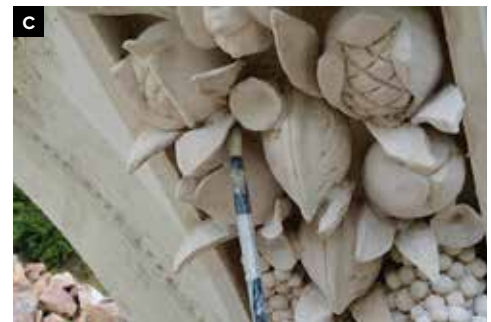
29 Ukázka lepení malých tvarů. Výroba repliky drobných štukových doplňků vychází ze studia originálů a jejich zakřivení – výběr vhodných lístků (A). Postup lepení lístků (B–C).
