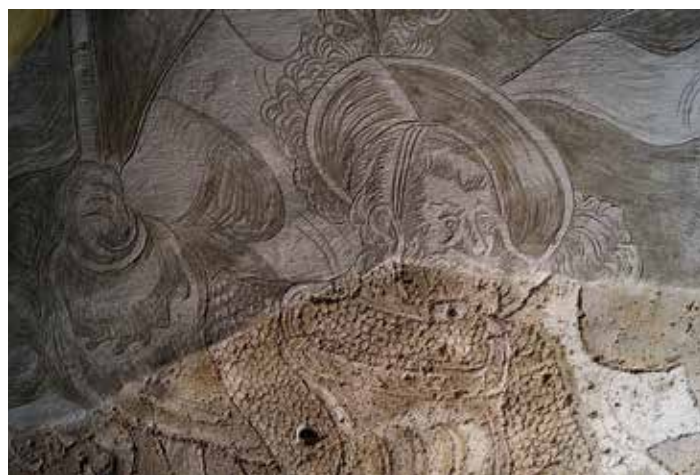
25 Původní a rekonstruované sgrafitto stínované prokletováním před patinací a retuší v šikmo dopadajícím bočním světle. Rekonstrukce je provedena formou technologické kopie.
