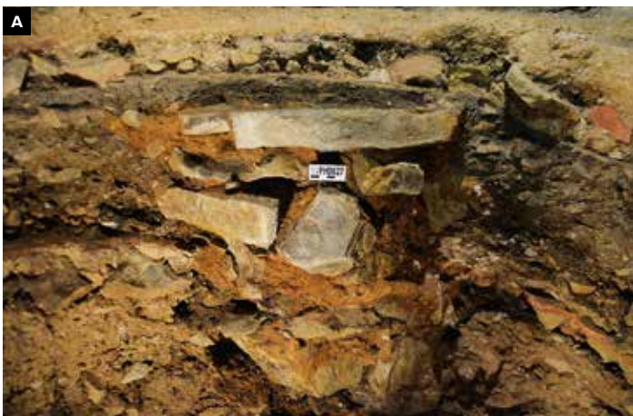
18 Základový pilíř odkrytý v archeologické sondě v podlaze kaple sv. Bartoloměje (A). Pražský hrad, vzorek PH 27 (B). Malta se jeví jako chudá na pojivo, ale vápno tvoří až několik cm velké shluky. Z odebraného vzorku je zřejmé, že vápna nebylo přidáno tak málo, jak se na první pohled zdá, ale při ledabylém promíchání během hašení s pískem se nevytvořila homogenní maltová směs.
