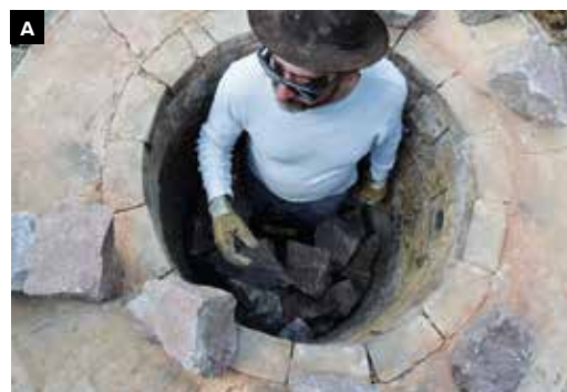
27 Dokumentace stavby klenby topeniště (A) a příkládání v pokročilém stadiu výpalu (B). Výpal sliveneckého vápence v roce 2019.
