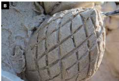
30 Ukázka přilepení ovocného prvku a jeho následného dotvarování přímo na stěně (A, B). Aplikace vápenného nátěru s klišem (C).
