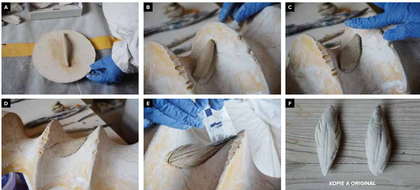
28 Výroba repliky lístku. Kónický váleček malty odpovídá velikosti modelovaného lístku, která je vyznačena na formě (A–C). Váleček se uválí rukou, následně se modeluje kovovou špachtlí včetně uhlazení a rýh (D, E). Po vyschnutí je možné porovnat výsledek s předlohou (F).
