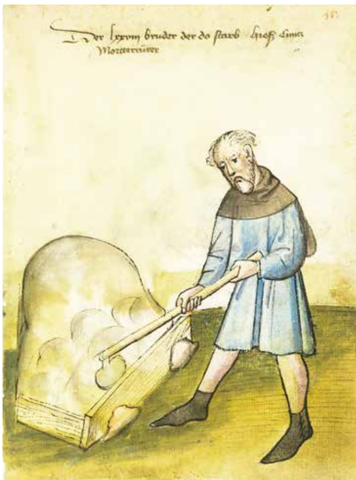
24 Historická ilustrace zobrazuje přípravu malty, okolí Norimberku, 1425. Typická je vysoká hromada malty a míchání motykou. Stavební dělník Cuncz Mortterrurer byl zvěčněn při výkonu své profese přípravě malty na památku díky Mendlově nadaci. Die Hausbücher der Nürnberger Zwölfbrüderstiftungen, Amb. 317,2 ° Folio 36 recto (Mendel I), odkaz https://hausbuecher.nuernberg.de/75-Amb-2-317-36-r/data .
