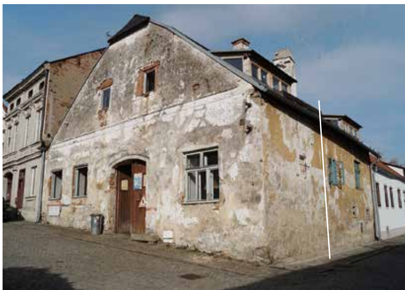
1 Slavonice, dům čp. 545 před počátkem rekonstrukce v r. 2015. Linie naznačuje rozhraní mezi jeho dvěma renesančními stavebními fázemi.
