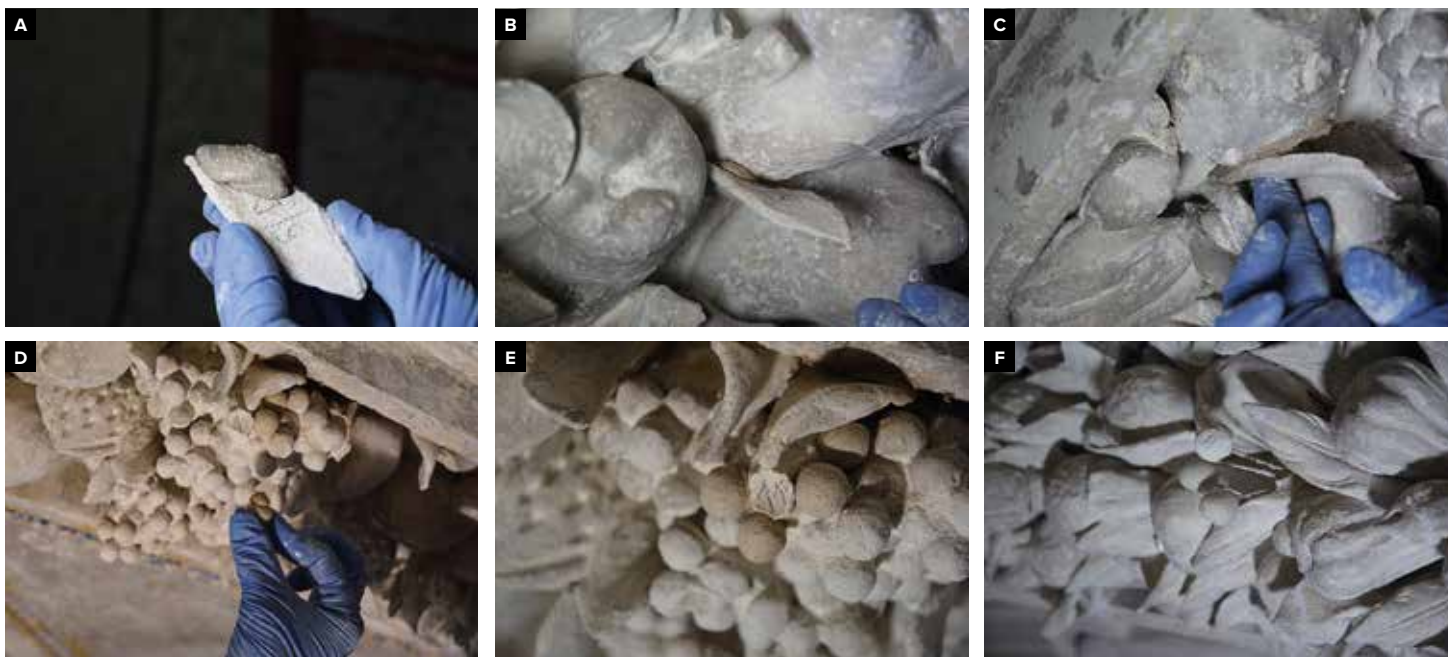
37 Osazování repliky drobných štukových doplňků. Ukázka z lepení lístků (A–C), doplňování kuliček do hroznu vína (D–E) a třešní (F).
