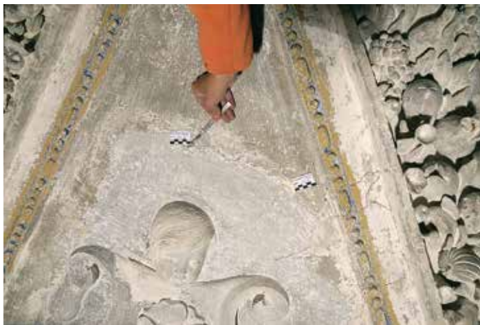
2 Luneta klenby; skalpel poukazuje na výrazné rozhraní mezi omítkou starší fáze a omítkou cometovských štuků, která je světlejší.
