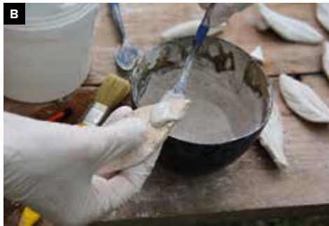
29 Ukázka lepení malých tvarů. Výroba repliky drobných štukových doplňků vychází ze studia originálů a jejich zakřivení – výběr vhodných lístků (A). Postup lepení lístků (B–C).
