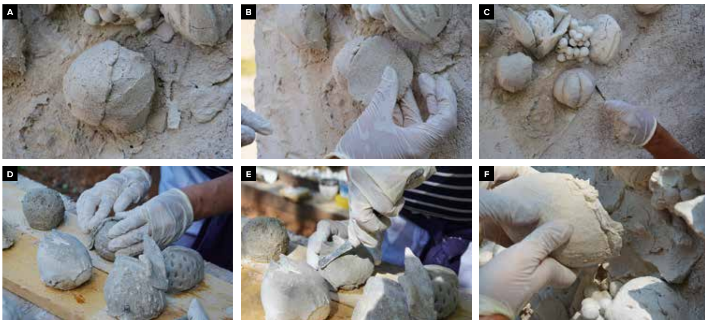
25 Ukázky postupu při modelaci ovocných tvarů z ruky na klenbě (A–C) a na stole (D–F).
