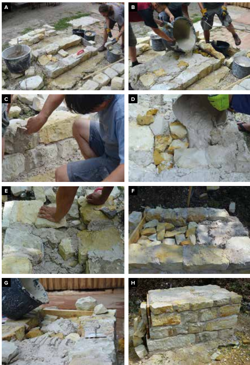
14 Experimentální stavba opukové zdi. Položení první řady kvádrů a vyzdívání jádra (A). Lítí horké malty do jádra prvního řádku (B). Spárování kvádrů po osazení do líce (C). Lítí 80 °C horké směsí, při kterém se rychle odvodňovala a tuhla (D). Vyzdívání jádra třetího řádku (E). Příprava na lítí jádra ve čtvrtém řádku (F). Postup při zalévání kamenů v jádru čtvrtého řádku (G). Hotová experimentální zeď (H).
