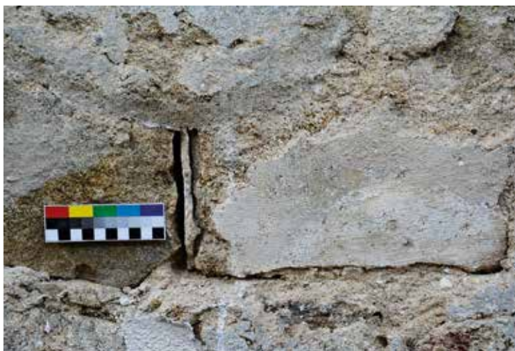
2 Slavonice, dům čp. 545. V přední části domu byl pod sgrafitovou bosází ve zdivu nalezen druhotně použitý rohový kámen potažený sgrafitovou omítkou (totožnou s omítkou landsknechtů z první renesanční fáze). Velmi pravděpodobně jde o kámen opětovně použitý při druhé renesanční přestavbě objektu.
