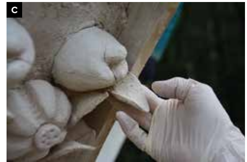
29 Ukázka lepení malých tvarů. Výroba repliky drobných štukových doplňků vychází ze studia originálů a jejich zakřivení – výběr vhodných lístků (A). Postup lepení lístků (B–C).
