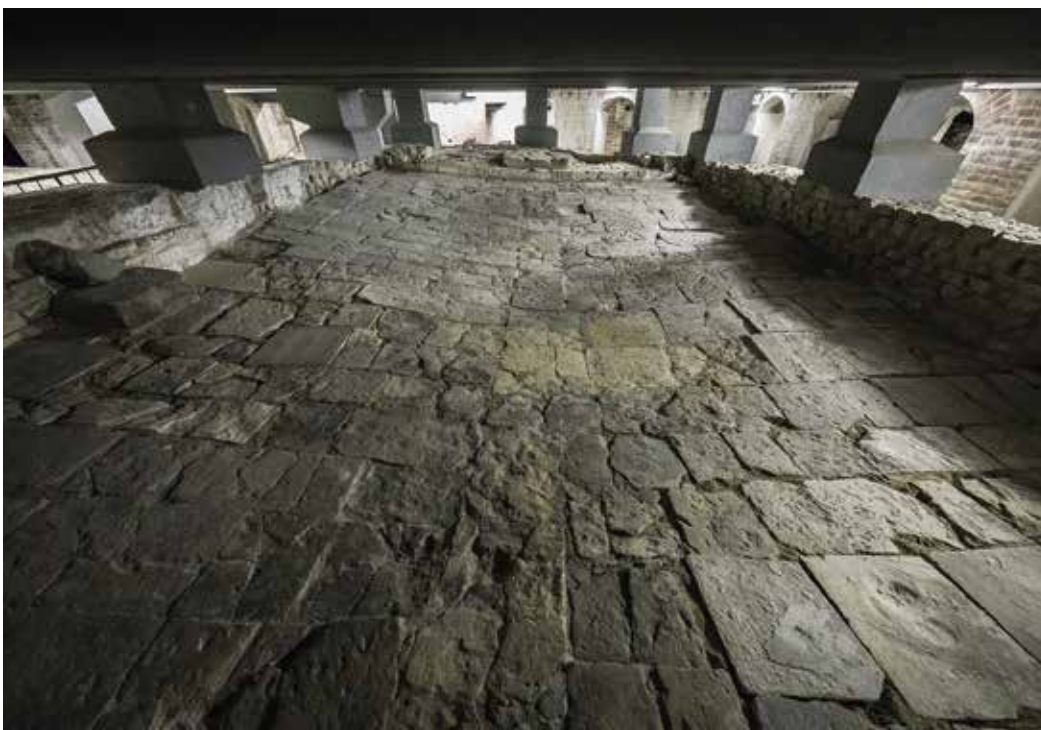
14 Pohled na opukovou dlažbu podlahy kaple zvané sv. Bartoloměje. Uprostřed je zřetelně vidět, jak se podlahové vrstvy propadly. Foto M. Frouz.
