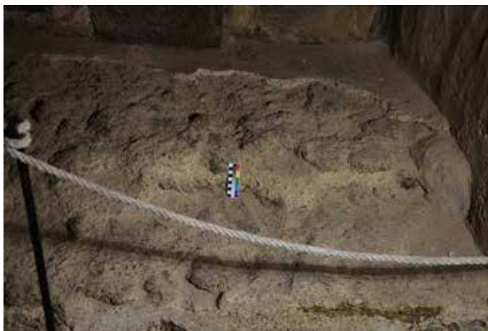
8 Podlaha s maltovou povrchovou vrstvou. Románská věž s kaplí, hrad Landštejn.
