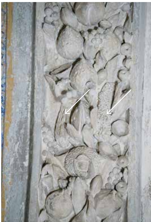
24 Detail ovocných tvarů, šišky modelované přímo na klenbě.
