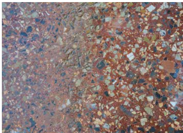
21 Detail vybroušeného povrchu terrazzo po navlhčení, vlevo je podlaha vybroušena kameny, v pravé části je dokonaleji vybroušena a vyleštěna elektrickou bruskou, uprostřed v přechodové části je vidět nezbroušený povrch.
