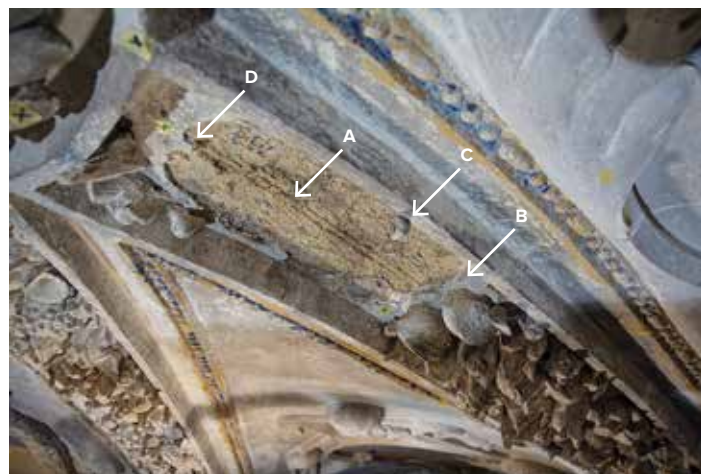
13 Detail štukového žebra v vrcholu lunety napojeného na kruhový lem okolo středové růžice. Na snímku je zachycen stav před zpětným osazením ovoce. Na maltovém podkladu (A) jsou zbytky sádro-vápnenné hrubé lepicí malty (B), která ho plošně pokrývá. Menší tvary byly připevněny ke stranám žebra, popř. větších tvarů jemnou lepicí maltou (C). Nejvýše osazený tvar byl osazen na kotvicí hřeb v místě (D).
