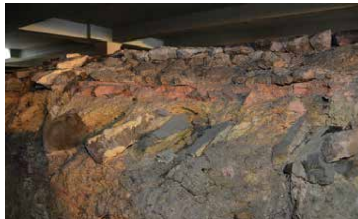
3 Souvrství s dlažbou, vrstvenými násypy a základem z mohutných kamenů. Kaple sv. Mořice, Pražský hrad.
