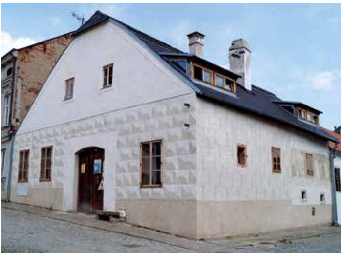
29 Dům čp. 545 ve Slavonicích po dokončení restaurování vnějších sgrafitových omítek v roce 2017.
