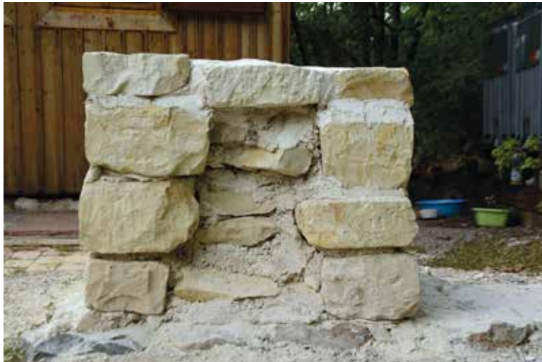
16 Pohled na jádro zdiva vyzdívané po řádcích. Do jádra se nejprve vpravila malta, do které se pak skládaly jednotlivé kameny.
