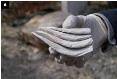
29 Ukázka lepení malých tvarů. Výroba repliky drobných štukových doplňků vychází ze studia originálů a jejich zakřivení – výběr vhodných lístků (A). Postup lepení lístků (B–C).
