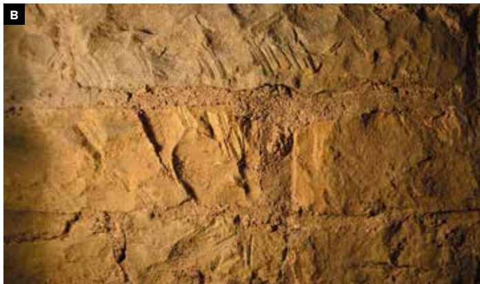
3 Řádkové opukové zdivo vnitřní zdi kaple se šikmou úpravou ložných i styčných maltových spár (A). Detail ukazuje kvalitu spárování a vzájemných podříznutí či překrytí mezi ložnými spárami a styčnou spárou. Na již zakončené styčné spáře je přilepen malý kus malty, který patrně spadl při zdění ve vyšších polohách (B). Pražský hrad, III. nádvoří, kaple zvané sv. Bartoloměje.
