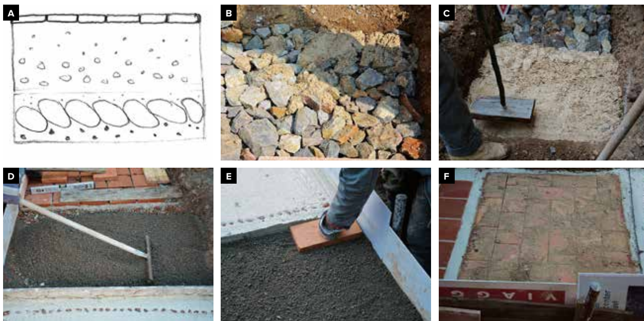
28 Postup výroby experimentální kopie třívrstvé podlahy s dlažbou.
