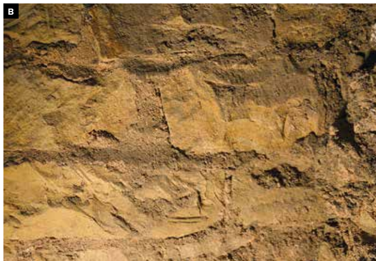
17 Spáry upravené stržením přebytečné malty a šikmým utažením zednickou lžící na zkušební zdi (A). Úprava spár interiérové strany románské zdi kaple zvané sv. Bartoloměje (B).
