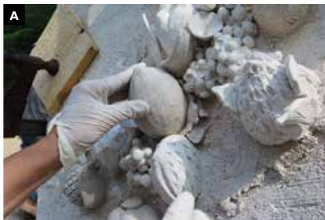
30 Ukázka přilepení ovocného prvku a jeho následného dotvarování přímo na stěně (A, B). Aplikace vápenného nátěru s klišem (C).
