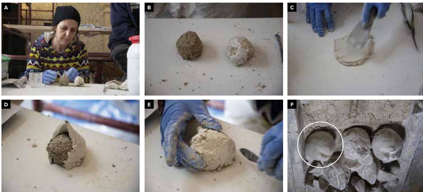
35 Výroba repliky. Výroba jádra (A, B), příprava štukové vrstvy (C) a její nanesení na jádro (D). Modelace tvaru pomocí špachtle (E) a přilepení na plánované místo (F).
