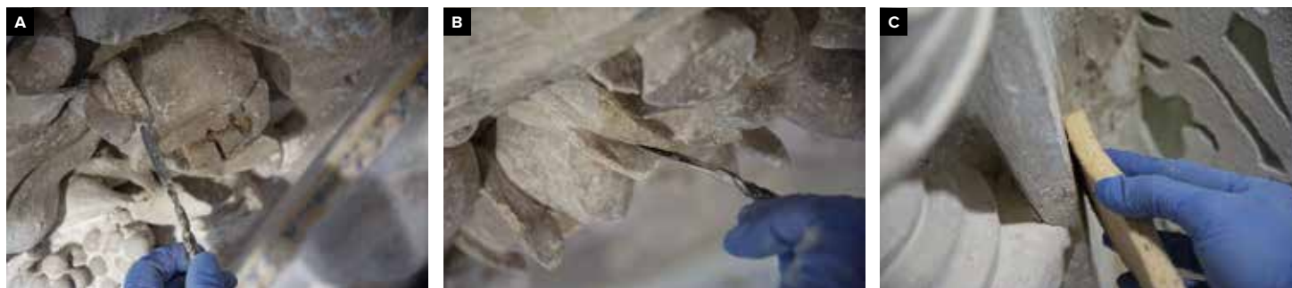
38 Maltové a štukové doplňky. Ukázka povrchového doplnění poškozeného ovoce (A), modelace chybějící špičky lístku (B) a úprava širší trhliny v maltovém žeburu (C).
