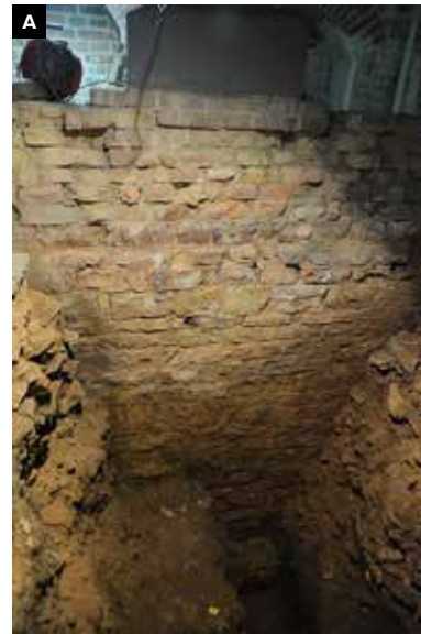
4 Interiérová strana jižní obvodové zdi kaple zvané sv. Bartoloměje odhalená sondou až k základu (A). Detail technologické spáry a místo odběru vzorku nad spárou v části poničené historickým požárem nad podlahou (B).
