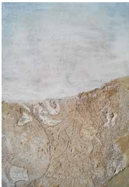
21 Vápenný nátěr nanesený na celý denní díl sgrafita ve dvou vrstvách. Do zaváděného povrchu nátěru je vtlačena přípravná kresba přes připravenou pauzu.
