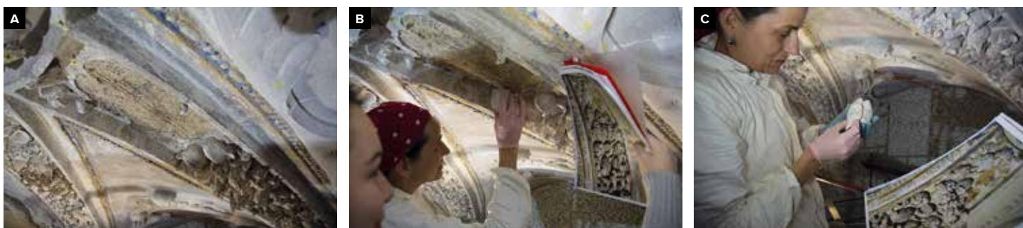
33 Příprava na zpětné osazení sejmutých tvarů. Kontrola podkladu (A), zkouška umístění jednotlivých tvarů podle fotodokumentace a označení (B, C).
