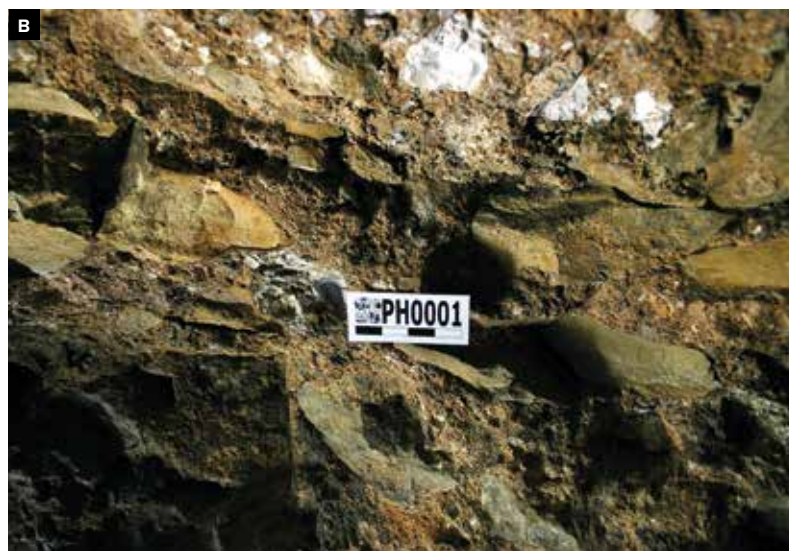
10 Pohled do průrazu románskou hradební zdí (A). Detail jádra zdiva. Místo s výskytem větších pojivových kusů (B). Hradba v tomto místě zároveň tvoří jižní obvodovou zeď knížecího paláce. Průraz románskou zdí, Pražský hrad.
