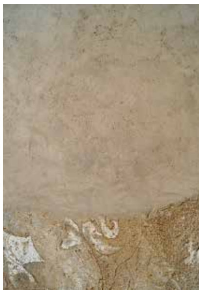
20 Druhá vrstva barevného intonaca po závěrečném vyhlazení.
