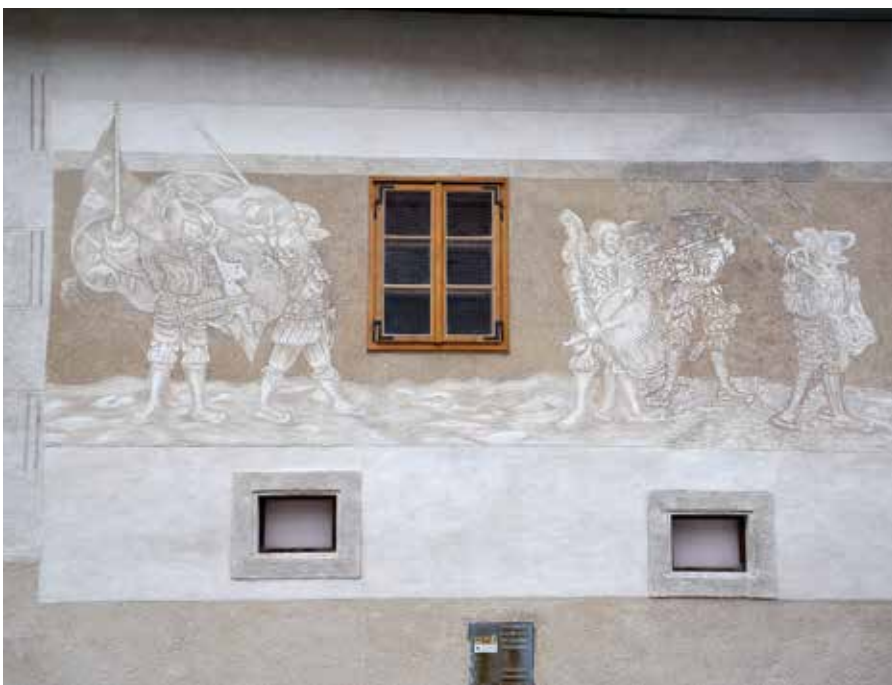
28 Dokončené sgrafito po závěrečné retuši a patinaci. Sgrafito je prezentováno analyticky, avšak zároveň tak, aby rozhraní mezi novými a starými částmi nerušilo.
