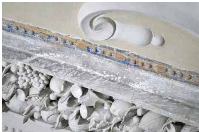
10 Část klenebního žebra s viditelnými cákanci.
