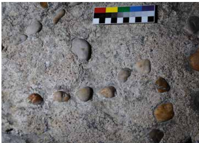
12 Detail povrchu s oblázkovou výzdobou. Místa jsou viditelné zbytky šedého znečištění. Oblázky ani malta nenesou stopy výrazné abraze ošlápáním.
