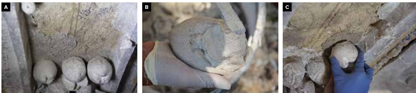
34 Lepení transferů. Nanesení lepicí malty na podklad (A) a na podstavu zpětně osazovaného ovoce (B). Lepený tvar lze přitlačit a udržet ve stabilní poloze rukou (C).
