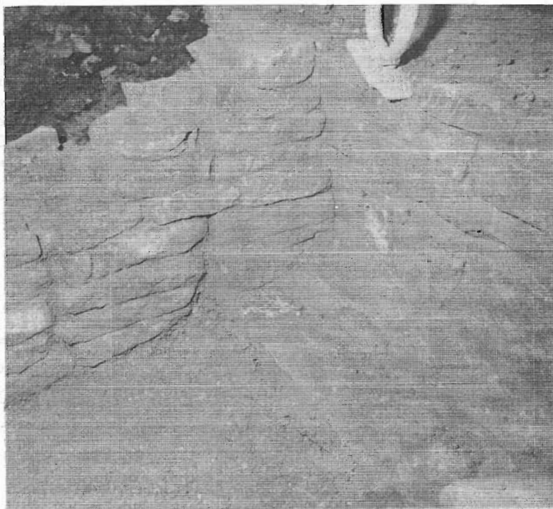
Obr. 8. Praha hrad, čp. 40. 1. místnost, sonda II. Styk starší /vpravo/ a mladší /vlevo/ zdi z 1. poloviny 13. století. Foto KP ČSSR. - Prague Castle, No. 40. First room, Sounding II. Contact of the earlier /right/ and later /left/ walls dated c. 1200-1250. Photo by the BP CSSR.
