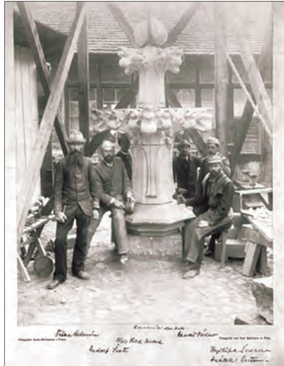
Abb. 4: Arbeiten des Dombauvereins.
