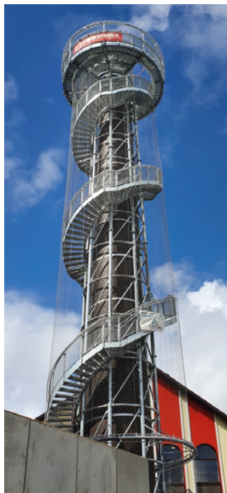
Obr. 1. Samonosná osmiboká rozhledna pivovaru Bernard a její 3D model. Foto: S. Hračov
