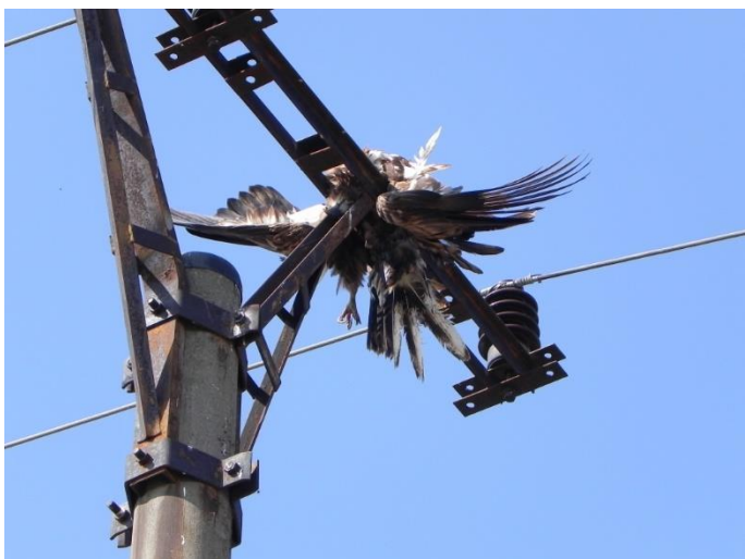
Dravec zabítý elektrickým výbojem na sloupu vysokého napětí FOTO: Vlasta Škopíková
