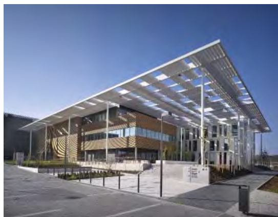
FZÚ AV ČR – pracoviště HiLASE v Dolních Břežanech
