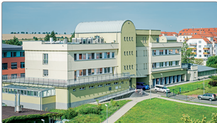
Rozvojevá 313, Prague 6 – Lysolaje (5 laboratories)
