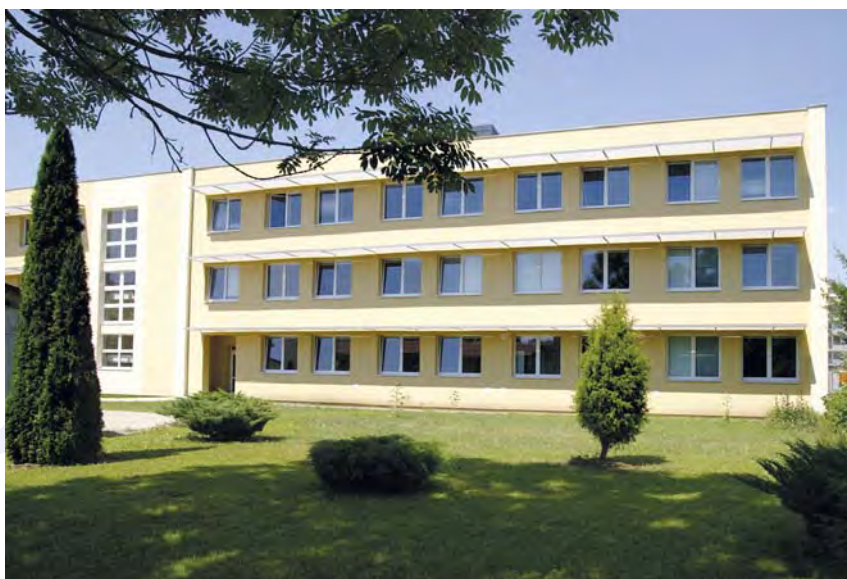
■ Obr. 1 Nová budova Střediska analýzy funkčních materiálů Fyzikálního ústavu AV ČR.
