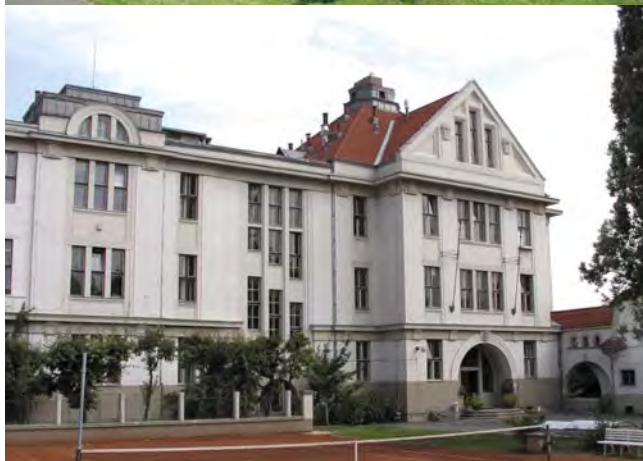
FZÚ AV ČR – pracoviště Cukrovarnická 10 v Praze 6
