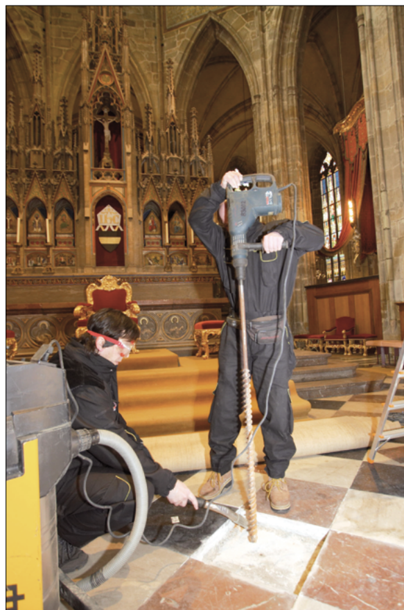
Obr. 59: Pražský hrad. Katedrála sv. Víta. Průzkum královské hrobky v roce 2005 – vrtání otvoru pro digitální videokameru v dlažbě katedrály. Archiv Archeologického ústavu AV ČR, Praha, v. v. i.
