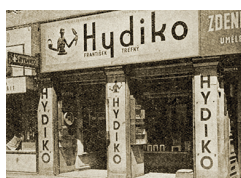
Portál firmy Hydiko ve Spálené ulici v Praze
