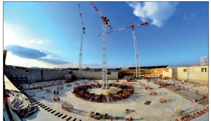
Obr. 7. Staveniště reaktoru ITER ve francouzském Cadarache [5]
