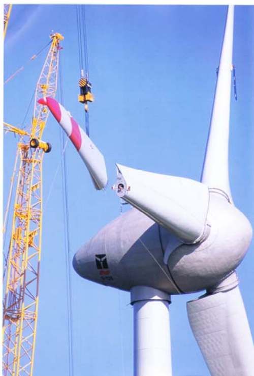
Obr.3 Montáž děleného listu rotoru větrné elektrárny Enercon E-126
