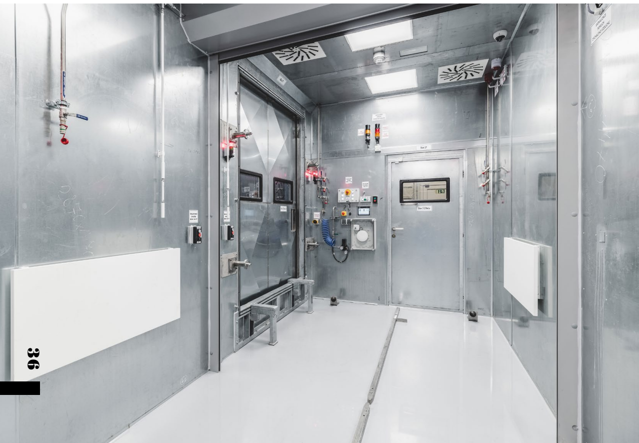
| Obr. 2: Přechodový box pro transport panelu do/ze zařízení HELCZA |
