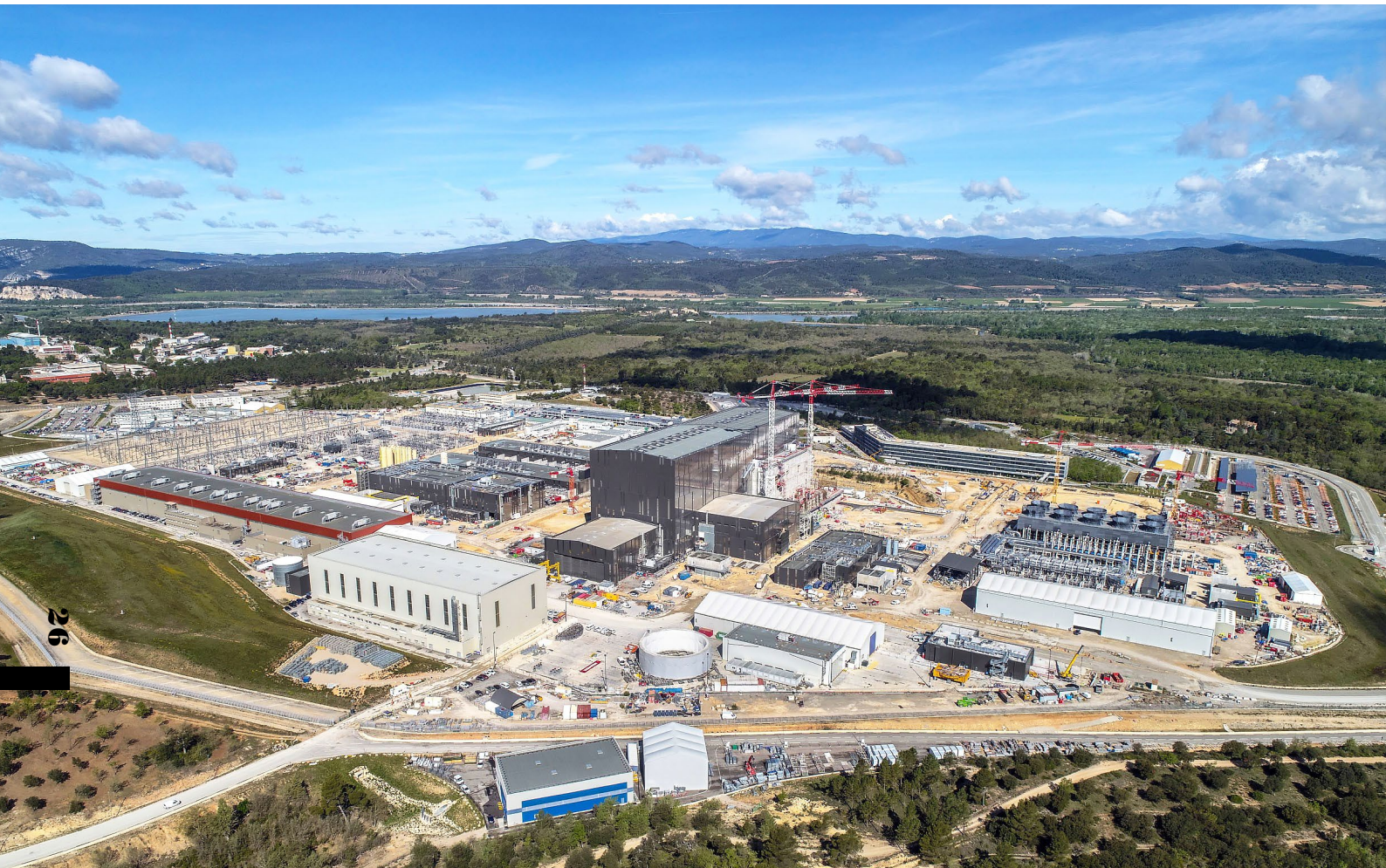
■ | Současný stav staveniště ITER (foto ITER) |
