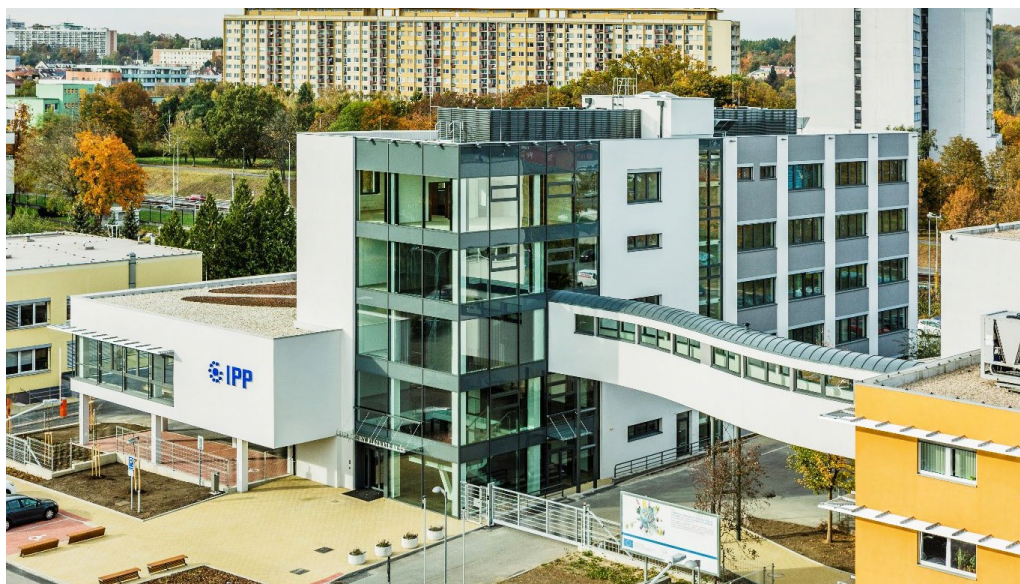
Obr. 6: Nová hlavní budova ÚFP dokončená v roce 2021
