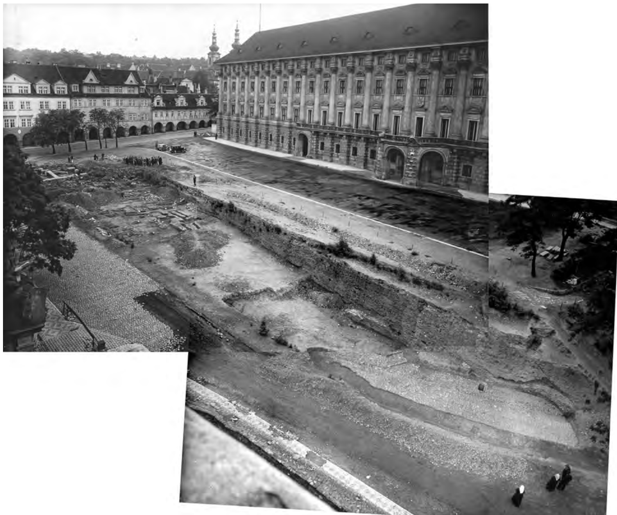
Obr. 38: Celkový pohled od severovýchodu na zkoumanou plochu Loretánského náměstí v srpnu 1935. Sesazení snímků č. neg. 73402 a 73227 I. Boháčová.
