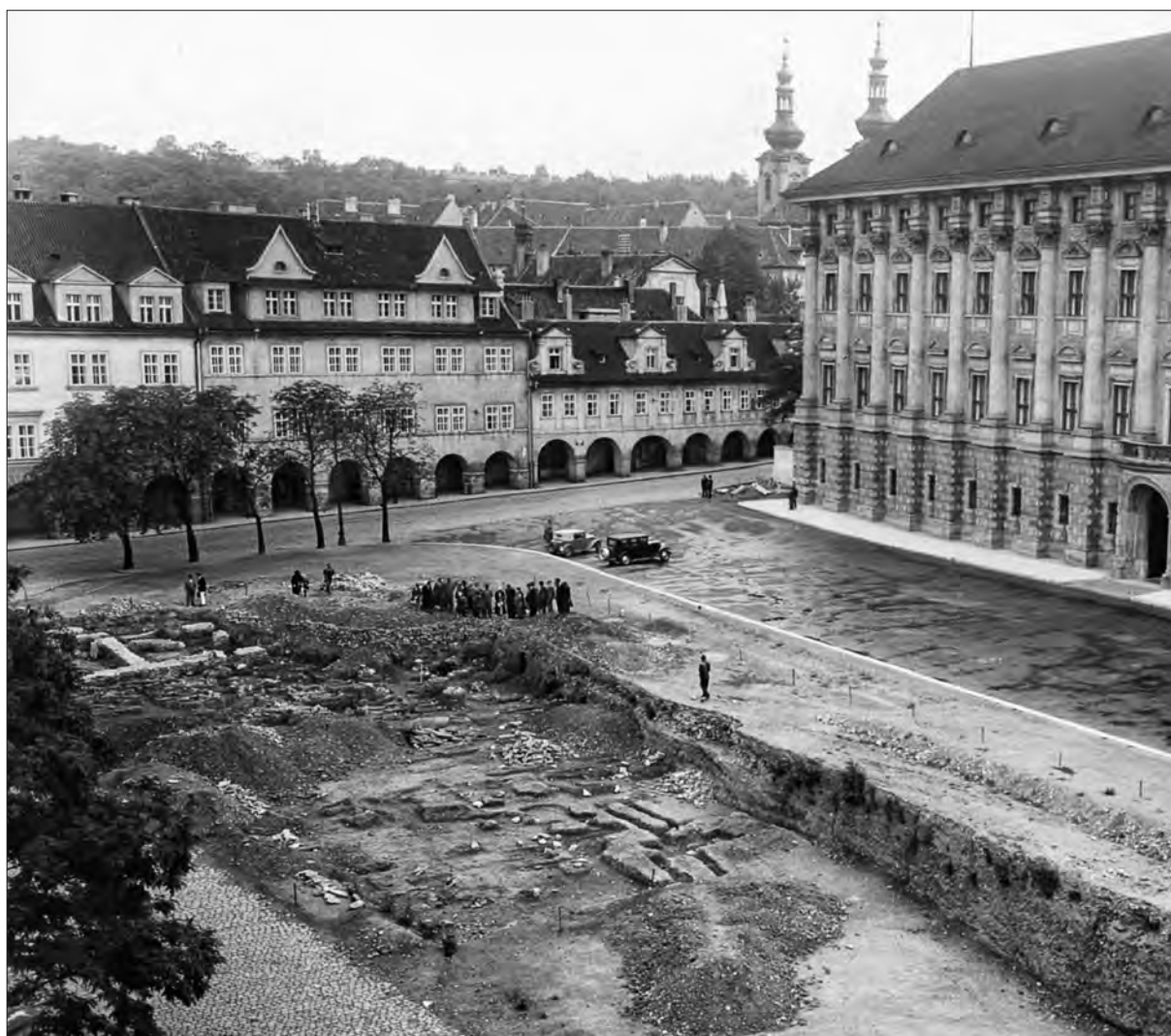
Obr. 39: Praha – Hradčany, Loretánské náměstí. Postup a metoda odkryvu – květen a červen 1935. Pohled od severovýchodu. Výřez (č. neg. 73402).
