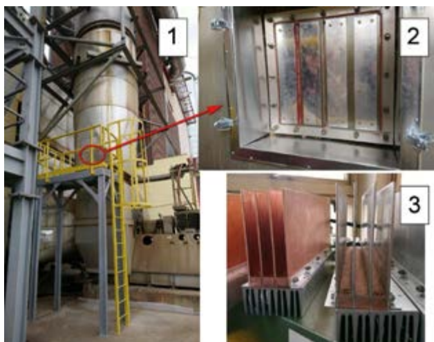
■ Obr. 39 Umístění termoelektrického generátoru na kouřovod (1), který je upravený pro testování speciálním otvorem (2) a umožní tak instalaci termoelektrického generátoru. Jeho jádrem budou tepelné výměníky, jejichž konstrukce je podpořena předběžnými výpočty (3).
