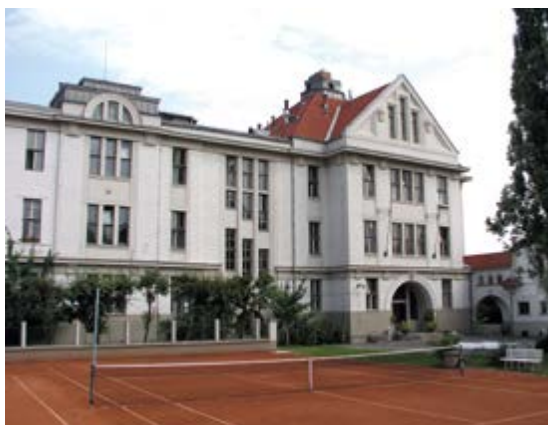
FZÚ AV ČR – pracoviště Cukrovarnická 10 v Praze 6
